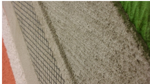
Abbildung 9: Systemaufbau eines rein mineralischen, dickschichtigen Wärmedämmverbundsystems mit Auszeichnung „Blauer Engel“
