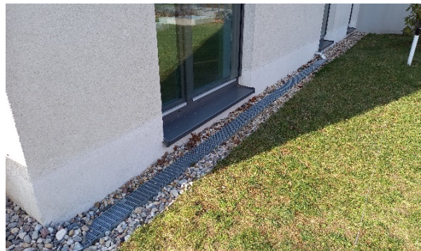
Abbildung 4: Geschützter Sockelbereich mit Fensterlaibung und umlaufender Drainage
