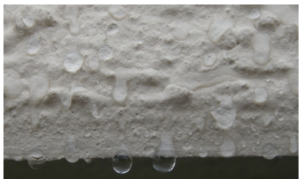
Abbildung 7: Fassadenabfluss auf hydrophober Beschichtung mit Kunstharz und Bioziden
