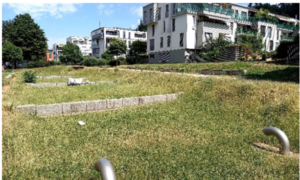
Abbildung 3: Staudenbepflanzung auf einer Versickerungsfläche mit Pflanzsubstrat
