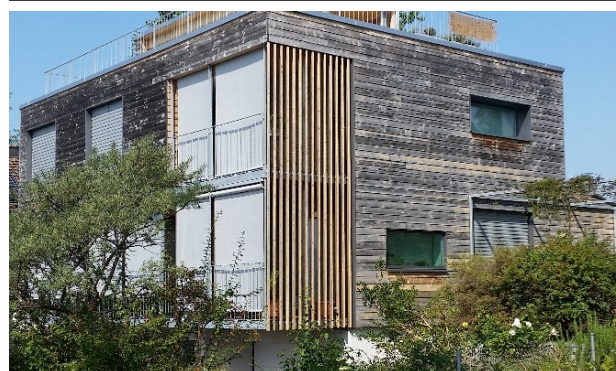
Abbildung 7: Holzfassade ohne chemischen Holzschutz
