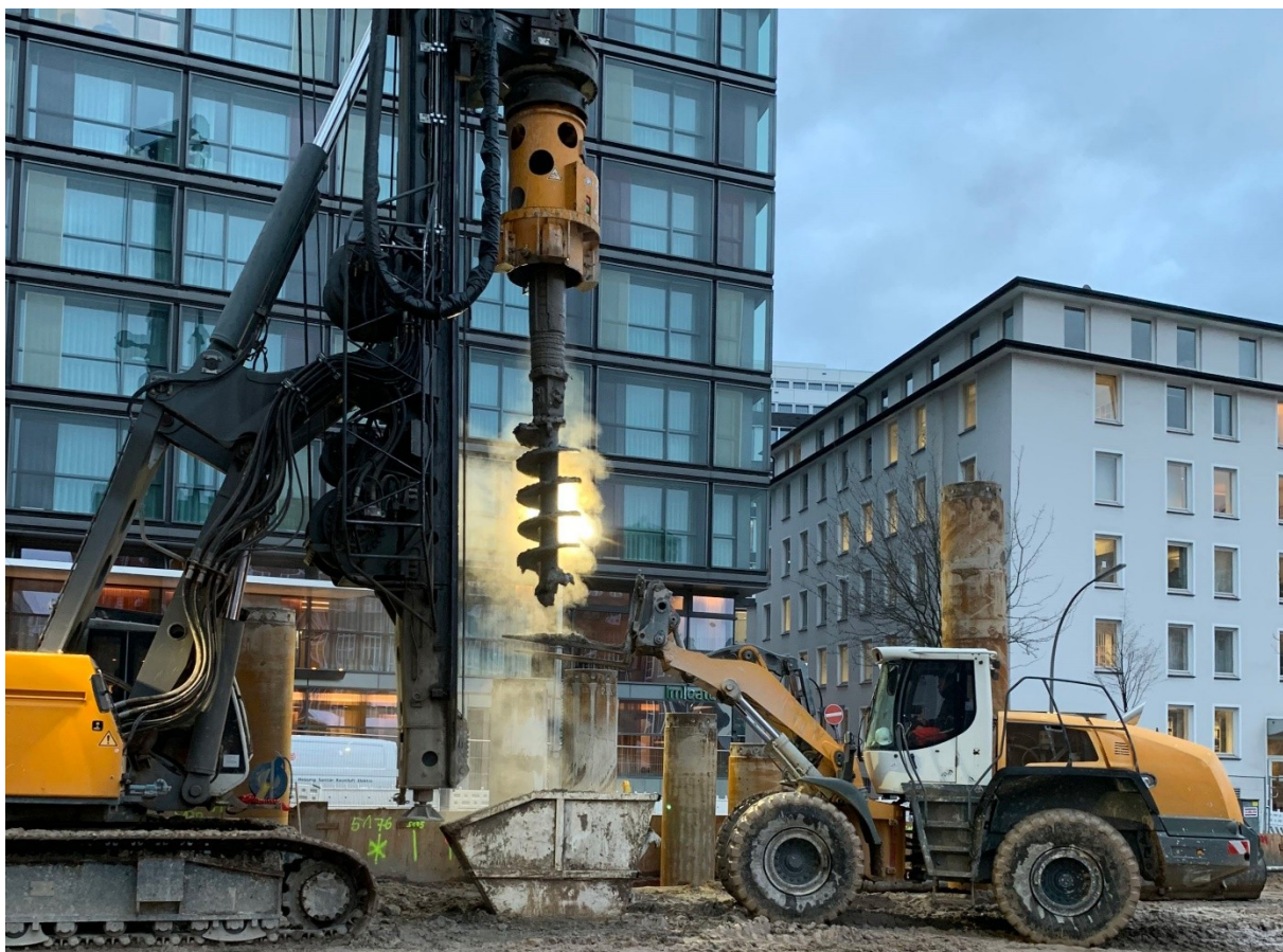
Abbildung 18: Leeren der Bohrschnecke durch Abstreifen (hier mit Radlader)
