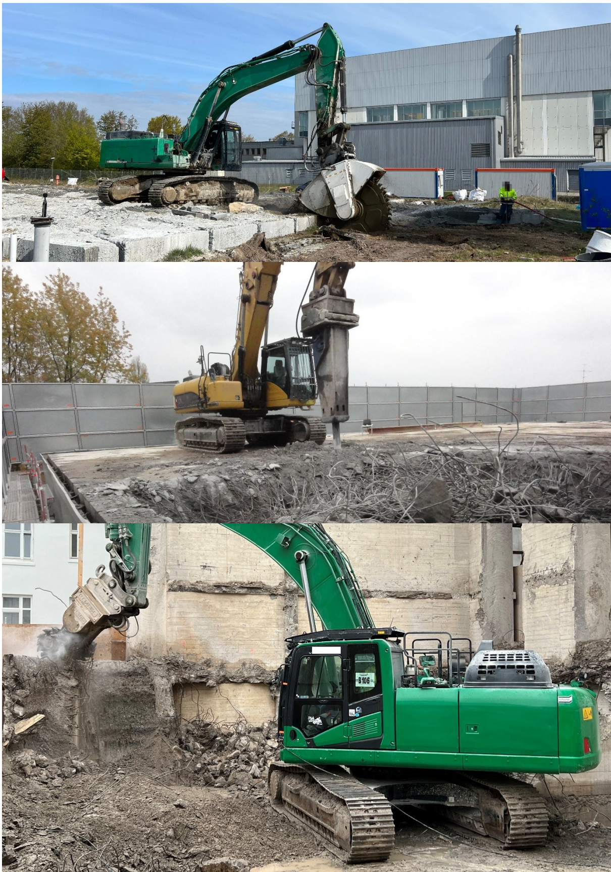
Abbildung 13: Hydraulikbagger mit Schneidrad, Hammer, Fräse (von oben nach unten)
