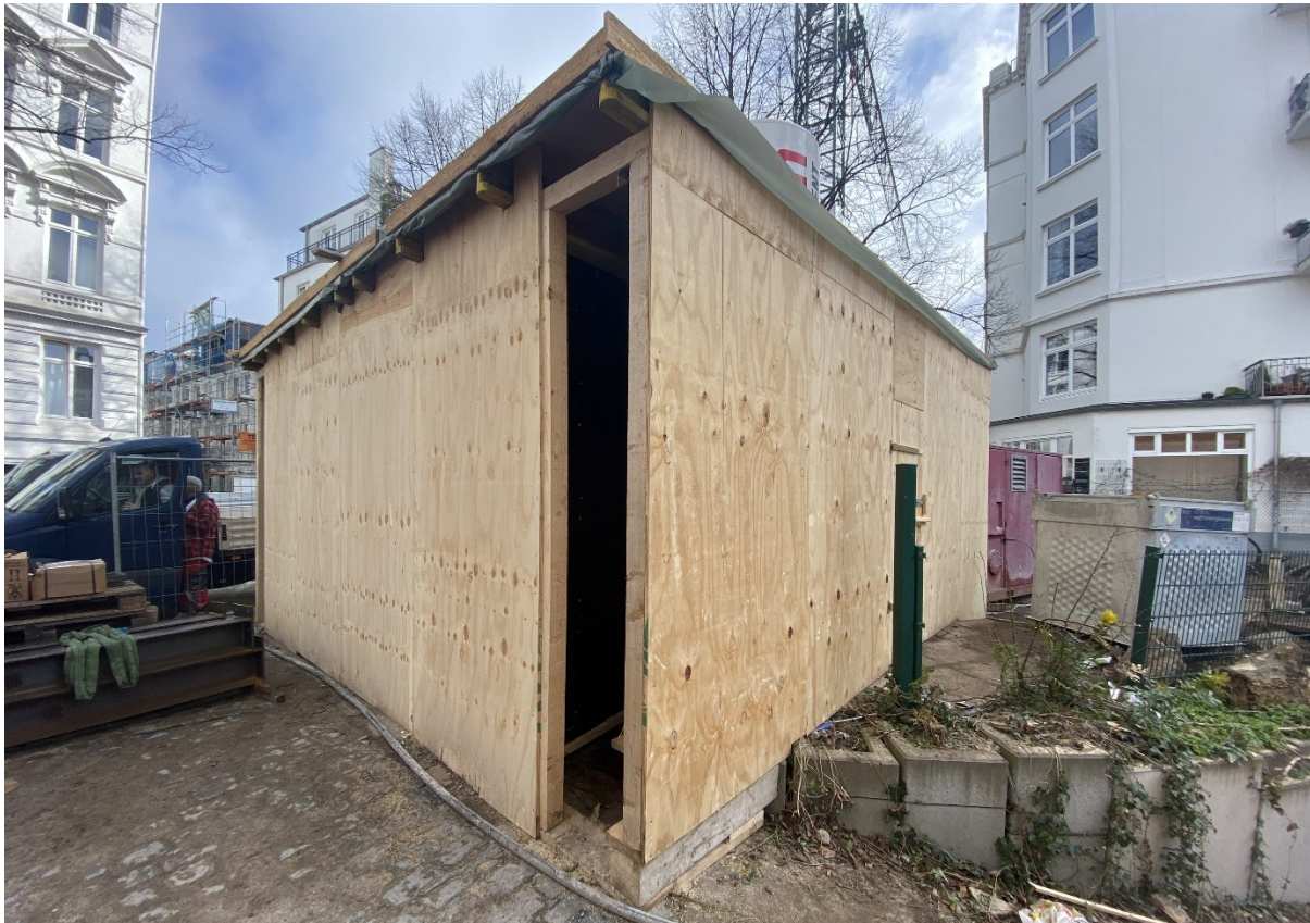
Abbildung 24: Einhausung für die Anwendung eines Höchstdruckwasserstrahls in einem Wohngebiet
