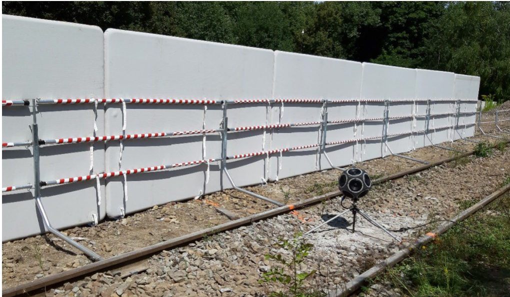
Abbildung 33: Schallschutzwand an einer festen Absperrung an der Schiene
