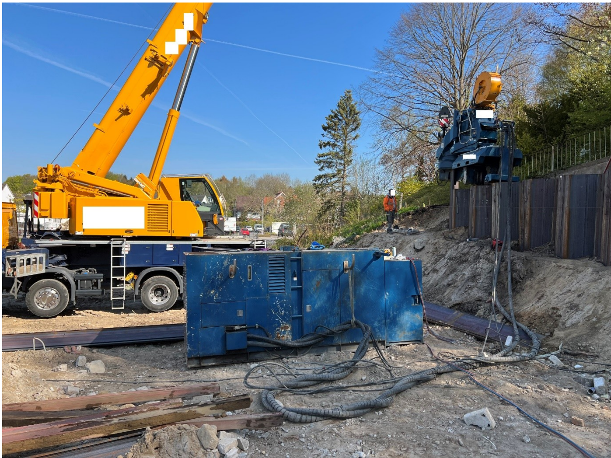
Abbildung 19: Pressen von Spundwänden mit Spundwandpresse und Hydraulikaggregat
