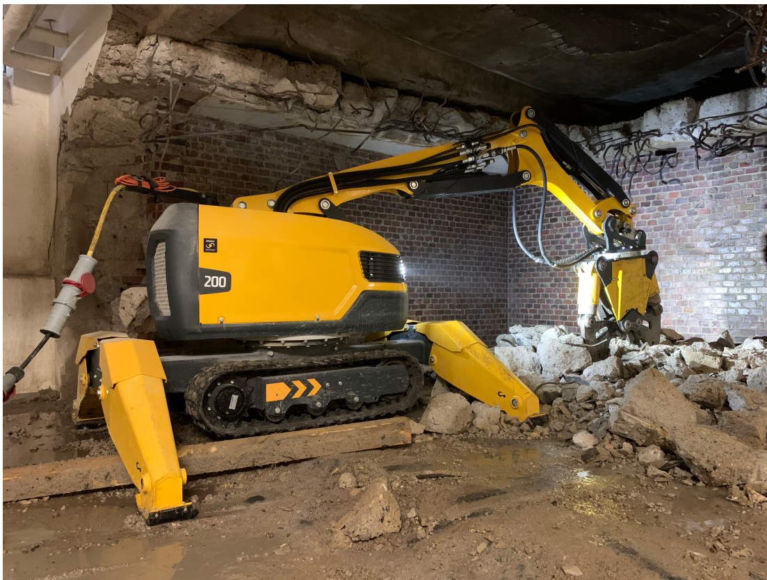
Abbildung 14: Elektrifizierter Bagger mit hydraulischer Zange bei Einsatz im Innenraum
