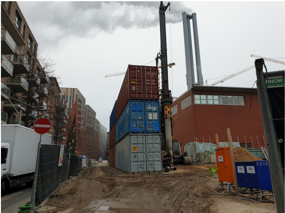
Abbildung 22: Temporäre Schallschutzwand aus Containern
