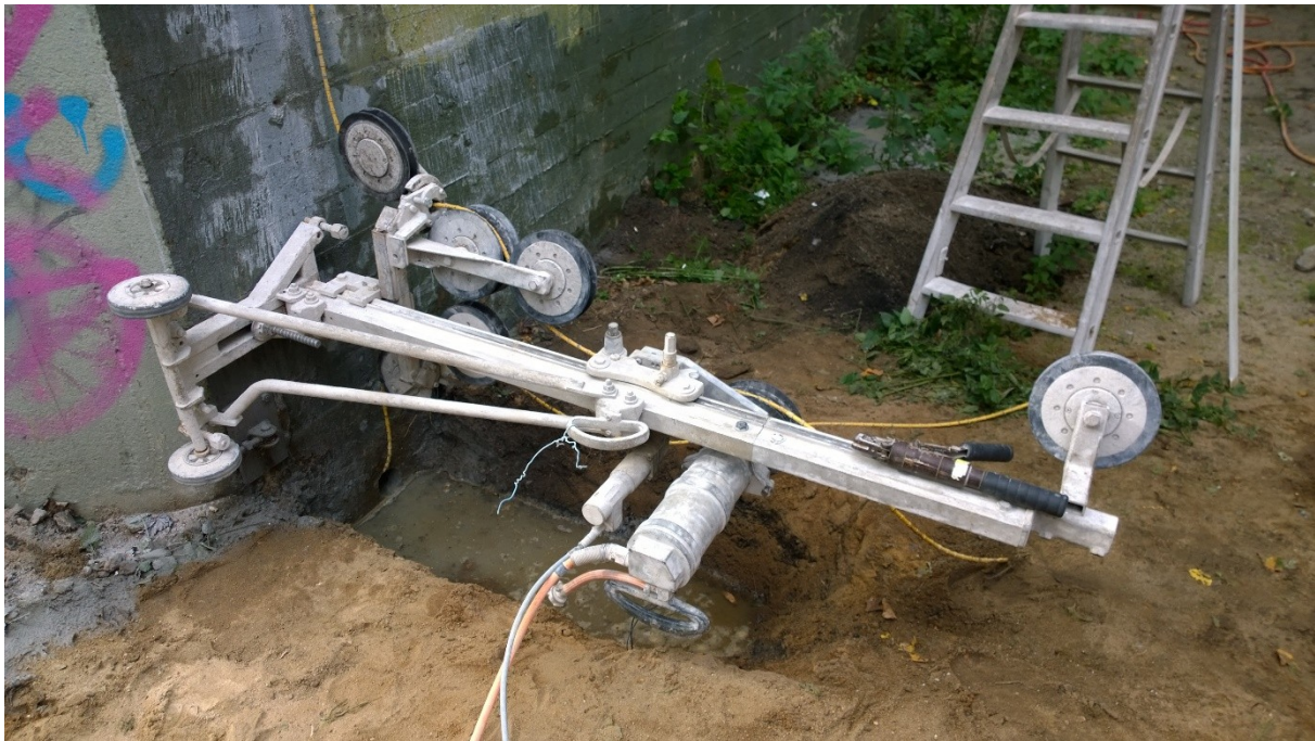
Abbildung 15: Einsatz einer Diamantseilsäge zum Zerkleinern von Beton
