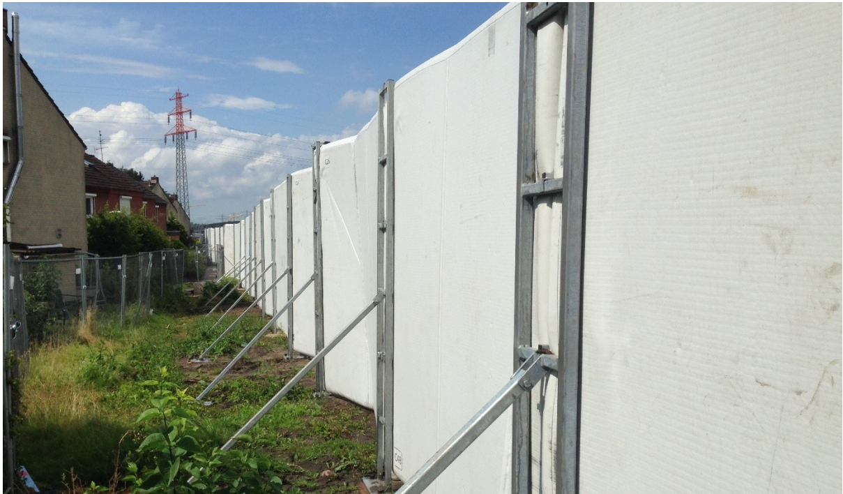
Abbildung 21: Temporäre Schallschutzwand mit Stützen zur Gewährleistung der Standsicherheit
