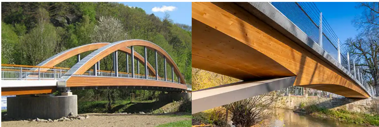
Abbildung 11: Moderner konstruktiver Holzschutz: Bogenbrücke über die Agger in Lohmar (links), Holz-Beton-Verbundbrücke über die Lindach in Schwäbisch-Hall (rechts)
