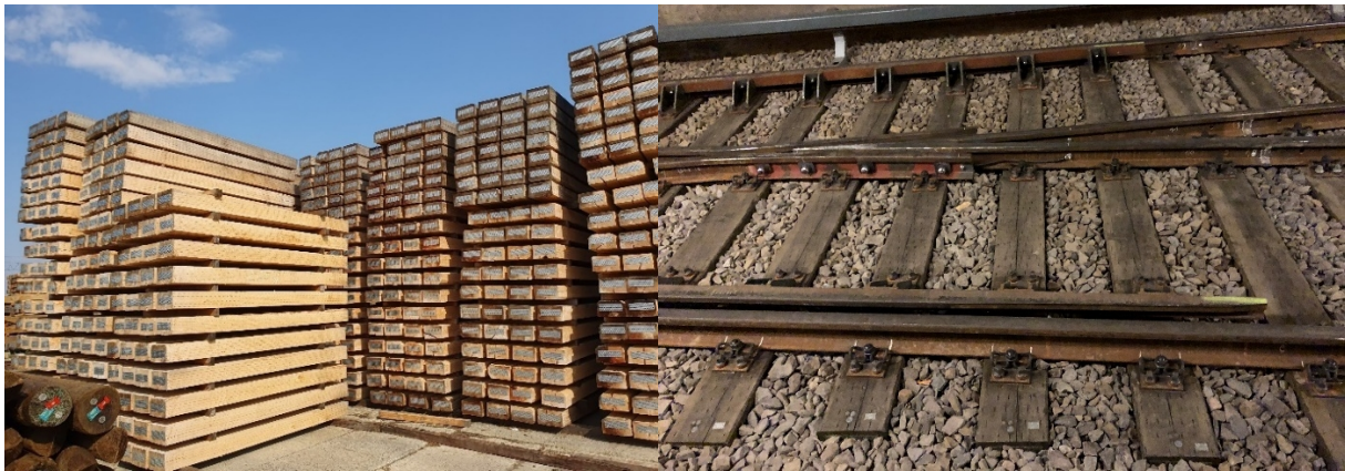
Abbildung 7: Eichenschwellen im Imprägnierwerk (links), Buchenschwellen im Gleis (rechts)
