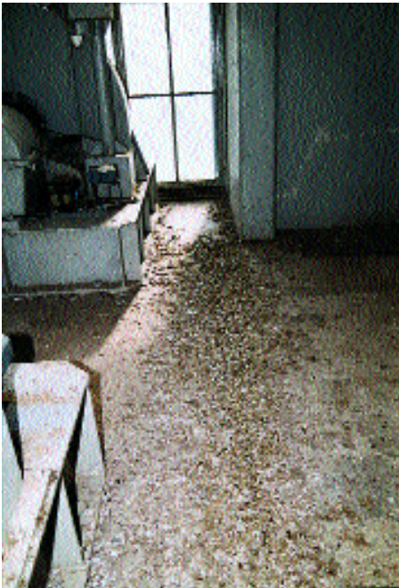
Abb. 10: Mit Taubenkot verunreinigter Maschinenraum eines Wehres in Brandenburg. Der Kot auf dem Fußboden sowie an den Maschinenteilen war überwiegend trocken. Zu Beginn der Messungen befanden sich einige Tauben im Raum
