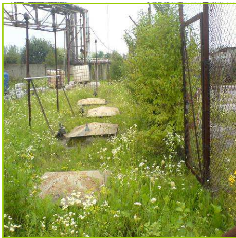
Nicht benutzter Lager für Ölprodukte / Zusammenlagerung mit Säuren
