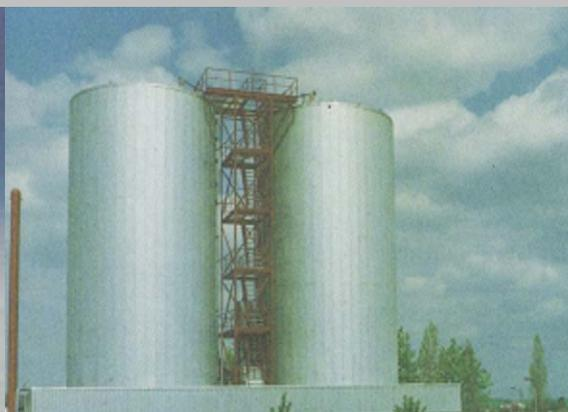
**Ilustración 34: Biorreactor para fermentación de desechos contaminados con sustancias orgánicas [15]**
