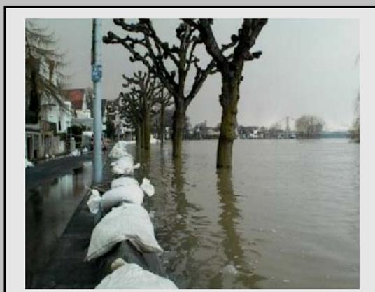
**Ilustración 17: Sacos de arena como protección contra la inundación / Inundación del Rin**
