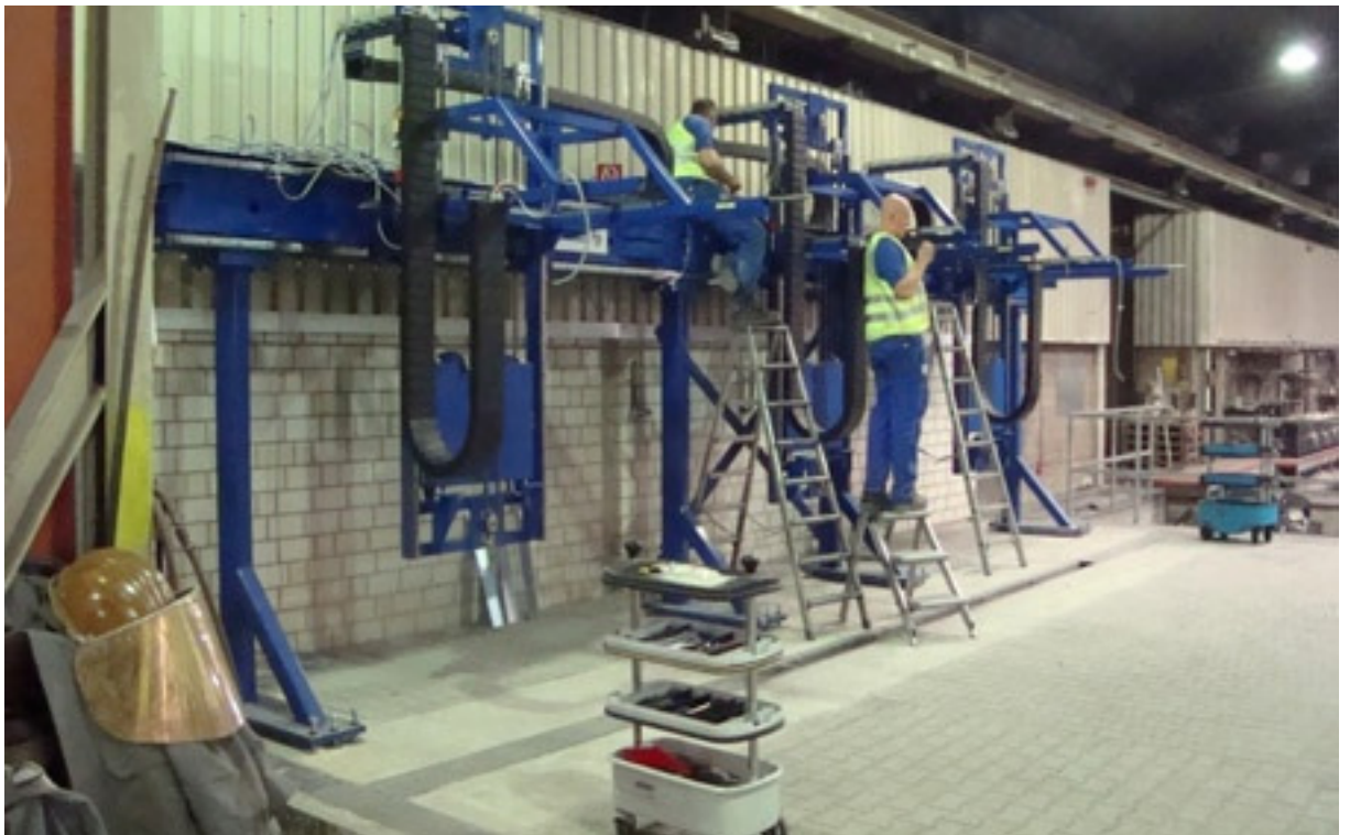
Abbildung 17: 3. Montage der Schlitten
