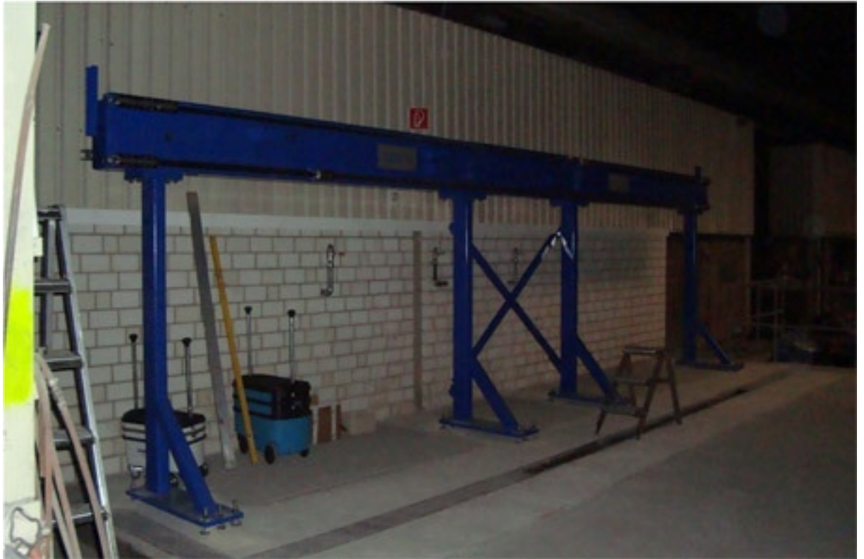
Abbildung 16: 2. Montage des Hauptträgers
