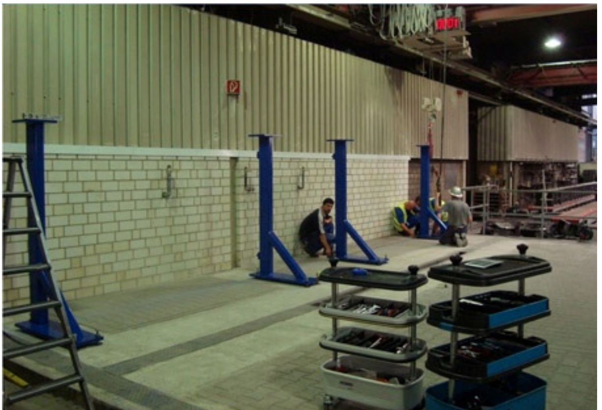
Abbildung 15: 1. Schritt aufstellen der Stützen
