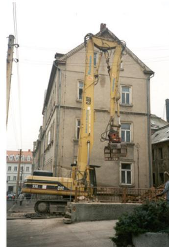
**Abbildung 4-2: Einsatz von High-Lift Technik für den Gebäuderückbau**
