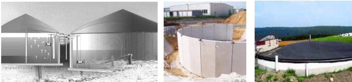
**Abbildung 3.2.1 Beispiele für vollandurchmischte Fermenter in Betonbauweise; Prinzipskizze des typischen Rundbehälters mit Rührwerken (links), Segmentbauweise (Mitte), abgesenkter Fermenter (rechts); Fotos: Biogas Nord GmbH (links), Drössler GmbH (Mitte), Energievision Frankenwald (rechts)**
