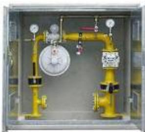
**Abbildung 3.3.10 Übergabe von aufbereitetem Biogas zur weiteren Nutzung mit einer Gaseinspeisestation**
