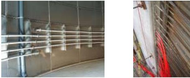
**Abbildung 3.2.13 Beispiele für integrierte Heizung; Heizrohre an Behälterinnenwand (links), Heizrohre bei Verlegung in die Wand, Sandwichbauweise (rechts); Fotos: Weltec Biopower (links), DBFZ (rechts)**
