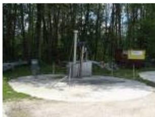
**Abbildung 3.1.11 Vorgrube - Unterflur mit Betondeckel, Foto: DBFZ**
