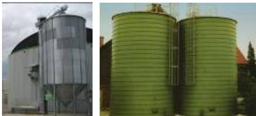
**Abbildung 3.1.7 Getreidesilo mit direkter Dosierung in den Fermenter (links); Hochsilos zur Flüssigkonservierung (rechts); Fotos: DBFZ (links), Lipp (rechts)**
