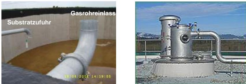
**Abbildung 3.3.1** Vorrichtungen zur störungsarmen Gasabfuhr; Links: Gasrohreinlass mit Öffnung nach oben (links die Substratzufuhr); Rechts: Gasdom mit hydraulischer Über-, Unterdrucksicherung sowie Schaumfalle und Gasabgang
