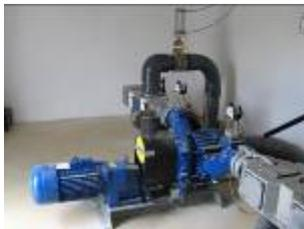
**Abbildung 3.1.25 Drehkolbenpumpe; Foto: DBFZ**
