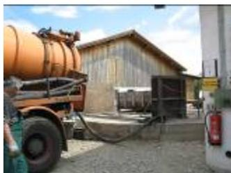
**Abbildung 3.1.4 Eintanken in eine geschlossene Vorgrube; Foto: DBFZ**
