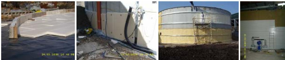
**Abbildung 3.2.14 Beispiele für Behälterisolierungen; von links: Bodenisolierung, Wandverkleidung im Bodenbereich, Sprühschaum, Trapezblechverkleidung quer an Boxenfermenter; Fotos: alle DBFZ, außer 3.v.l.: Pluimers Isolatie bv.**
