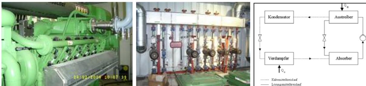
**Abbildung 3.3.8** Beispiele zur gekoppelten Kraft-Wärme-Erzeugung; Links: BHKW bei der Montage; Mitte: Wärmeauskopplung an Wärmeverteilstation; Rechts: Prinzip der Kälteerzeugung aus Wärme; Fotos: DBFZ
