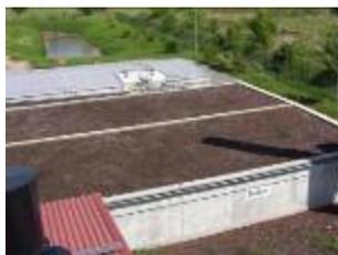
**Abbildung 5.1.3 Flächenbiofilter; Foto: DBFZ**
