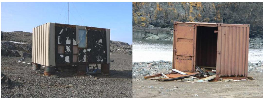
Abb. 4.2.-34a & b: Stark beschädigte Container an der Ostküste der Fildes Peninsula, a - Container nahe des Ardley-Isthmus, b - Container südlich von Great Wall (Fotos: Büßer)
