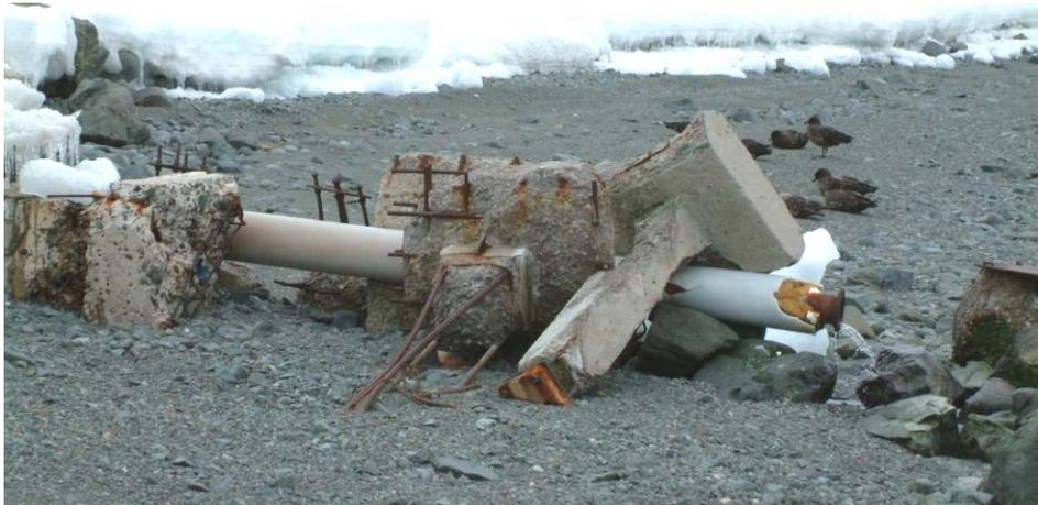
Abb. 4.3.-3: Bei Ebbe freiliegendes Endstück des Abwasserrohres von Great Wall (Foto: Dezember 2003, Büßer)
