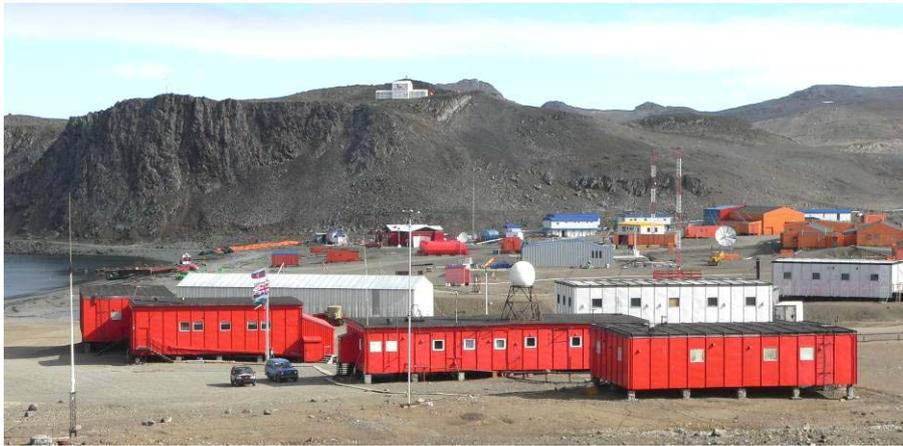
Abb. 4.2.-22: Die typische Stelzenbauweise am Beispiel der Hauptgebäude der Station Bellingshausen (Foto: Büßer)
