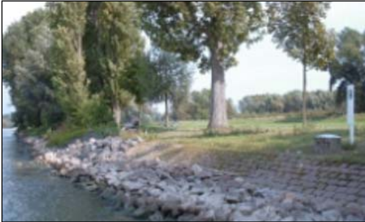
In Teibereichen massive Uferverbauung aus Verbundsteinen.
