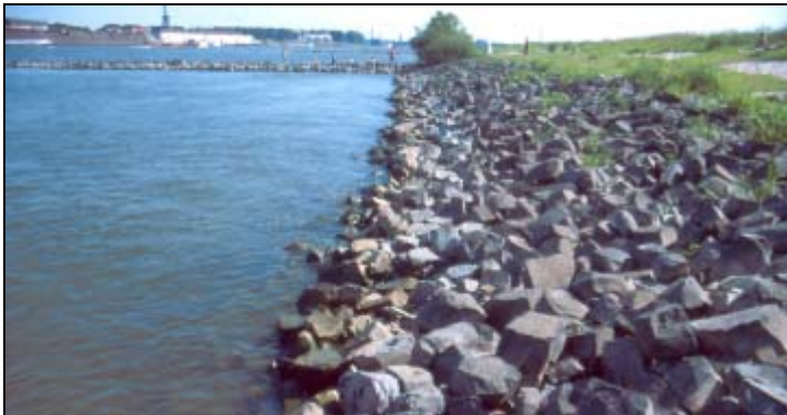
Zustand 2002: Steinschüttung sichert das Ufer.
