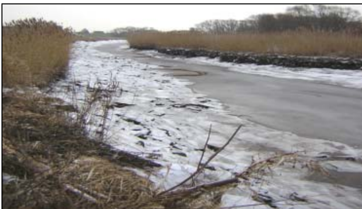
Aktuelle Situation (Januar 2006 Blick nach Osten) bei Niedrigwasser: Die mit Eis bedeckte Uferzone markiert den bei mittlerem Tidehochwasser überfluteten Bereich. Steinschüttungen sichern die Ufer.
