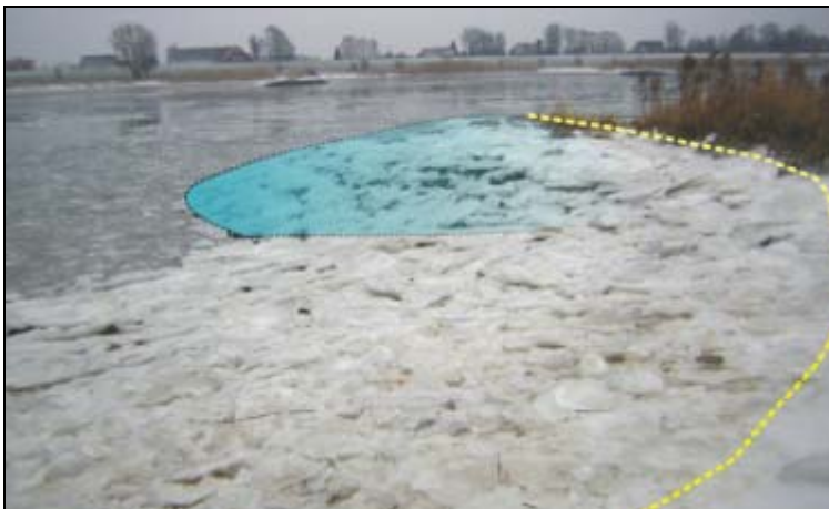
Januar 2006: Südlicher Abschluss des rückgebauten Deckwerkes. Der Unterschied in der Uferprofilgestaltung ist deutlich zu erkennen. Der Vergleich mit der Situation 2002 verdeutlicht die Entwicklung einer Hochstaudenflur oberhalb der Mittelwasserlinie. Röhricht hat sich noch nicht in größeren Beständen entwickelt.
