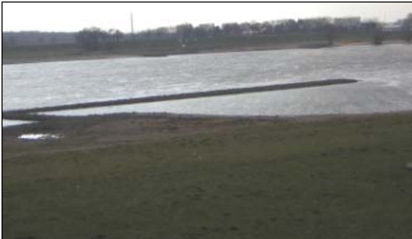
Abb. 50: Beispiel für die Umgestaltung einer Steinschüttung und Buhnengruppe zur Schaffung von ökologisch wirksamen Flachwasserzonen mit mildem Strömungsklima
