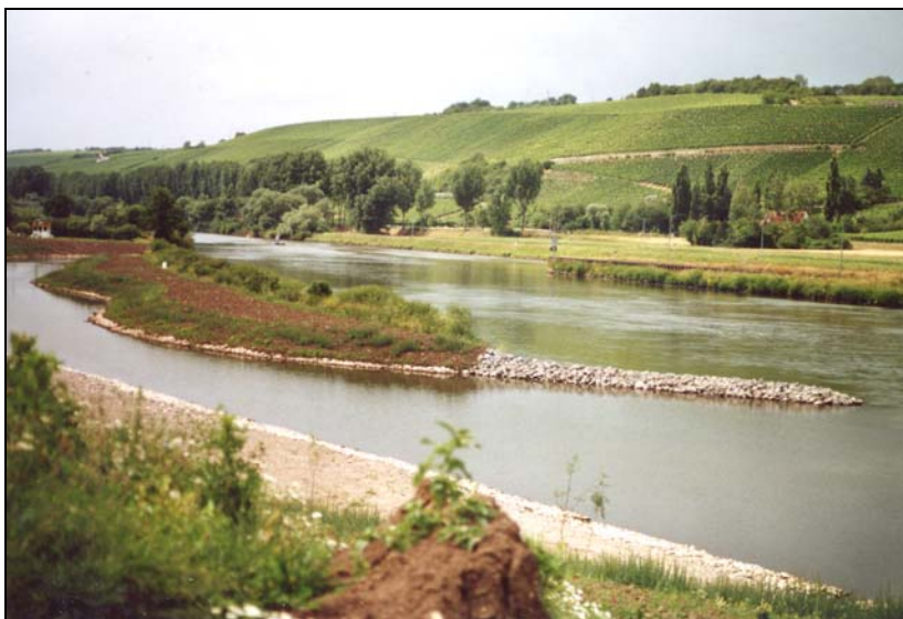
Abb. 49: Wellengeschützter Nebenarm am Main mit Mindestströmung durch Leitwerksgestaltung
