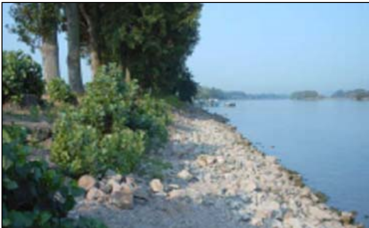
Die Teilstrecke war in den 50er Jahren durch eine Steinschüttung zu einem Ufer ohne Ufervegetation ausgebaut.
