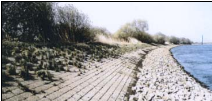
Situation noch Anfang der 90er Jahre: Mit Steinschüttung und Deckwerk gesicherter Deich im Bereich Spadenländer Busch.
