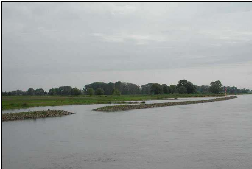
Abb. 48: Hakenbuhne und ökologisch optimiertes Leitwerk: Im Bereich der Mittleren Elbe werden zur Zeit verschiedene neue Formen von Strombauwerken in ihren ökologischen Auswirkungen untersucht und optimiert.
