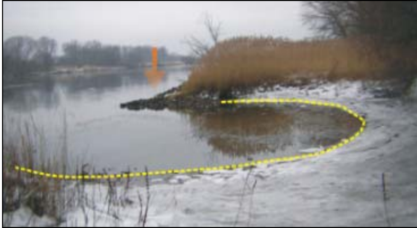
Abb. 51: Beispiel zur Schaffung eines kleinräumigen, naturnahen Uferprofils durch die Anlage von Schlenzen (Projekträger HPA, Hamburg Port Authority)
