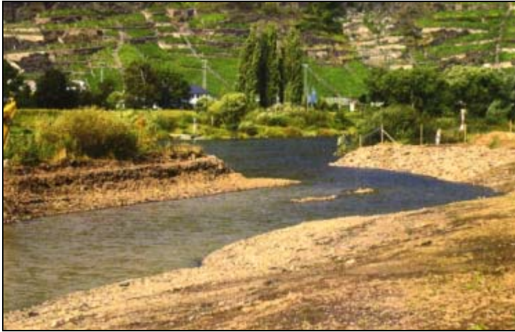
Blick auf das neugestaltete Uferprofil und die strömungs- und wellengeschützten Flachwasserbereiche. (Quelle: LENZ; S. 2006)
