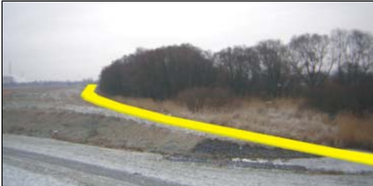
Situation Januar 2006: Blick vom neuen Deich am südlichen Ende der Deichrückverlegung nach Norden (Standort s. Übersichtkarte). Im Vordergrund sichtbar der ehemalige Verlauf der alten Deichtrasse mit der davor liegenden Auevegetation mit Weichholzaue und Tideröhricht des Deichvorlandes. Das Gelände binnenseits des alten Deiches ist noch nicht vollständig abgetragen. In den nächsten Jahren wird das Material abgetragen und das neue Vorlandprofil mit Priel (siehe Plan) hergestellt.
