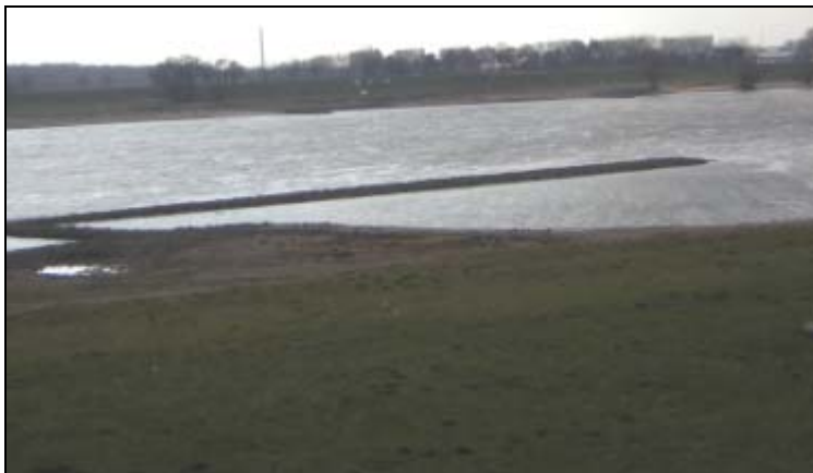
Februar 2006 (Niedrigwasserabfluss): Blick auf die neu entstandene Hakenbuhne ca. 200 m im Oberstrom der Entnahmestelle aus der Ufersicherung. Auch bei Niedrigwasser besteht jetzt eine ständige Verbindung zwischen Strom- und den jeweiligen Flachwasserbereichen.
