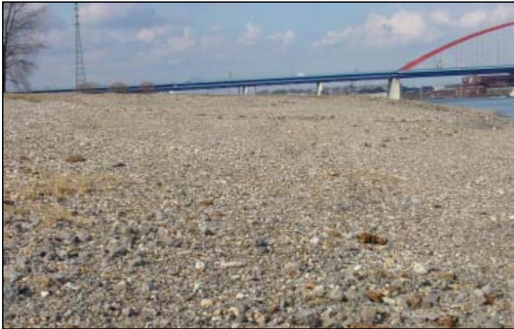
Situation 2005: Flaches Kies-/Sanduferprofil nach dem Auftragen entsprechenden Baggerguts.
