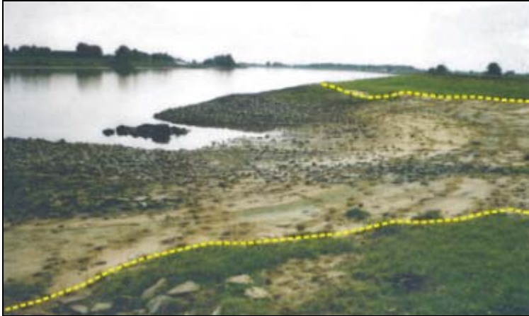
Sommeraspekt 2002: Blick auf das Ende der Rückbaustrecke mit dem noch vorhandenen Deckwerk im Hintergrund und einem zurückgebauten Uferabschnitt im Vordergrund.
