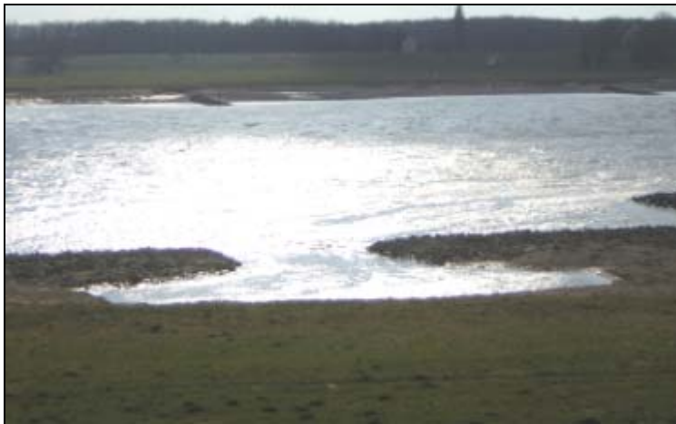
Februar 2006: Blick auf eine der Steinschüttungsunterbrechungen und Vorlandabgrabung bei Niedrigwasser.
