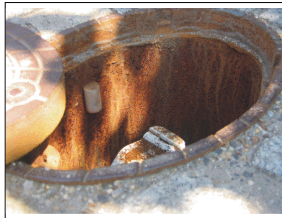
Bild 6 und 7 Anbringung von Transpondern im Betonschutzring und am Unterflurausbau
