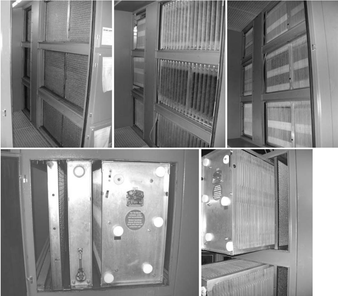
Bild 2.2: Aufbau der Elektrofiltermodule: Vorfilterstufe (oben links), Ionisatorstufe (oben mitte), Kollektorstufe (oben rechts), Anordnung der Zellen (unten links), Kollektorzellen der letzten Stufe mit Nachfiltern (unten rechts).
