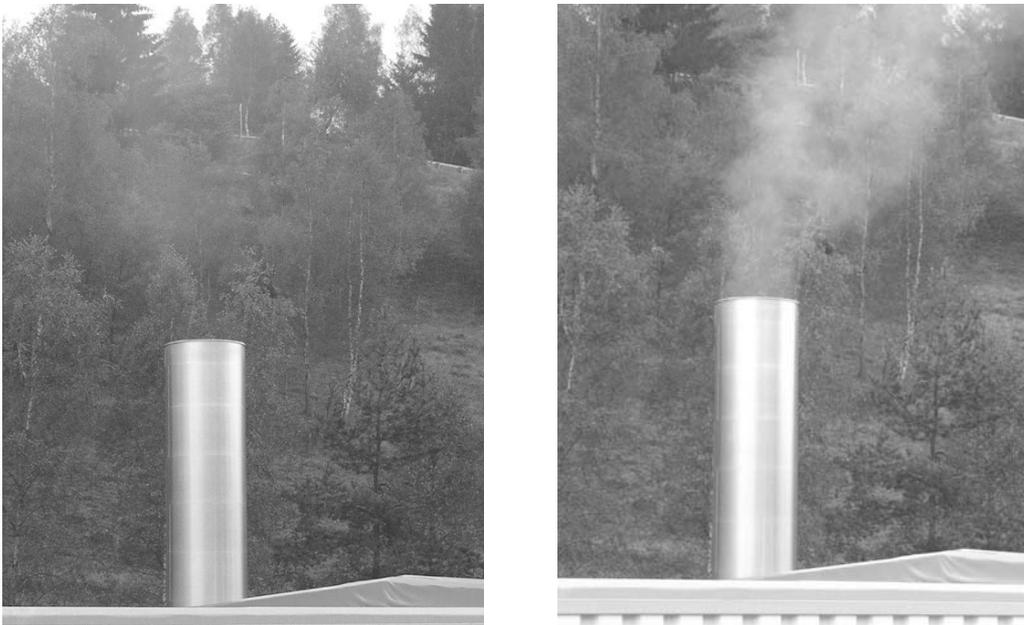
Bild 4.4: Nebelschwaden mit (links) und ohne (rechts) Filteranlagen
