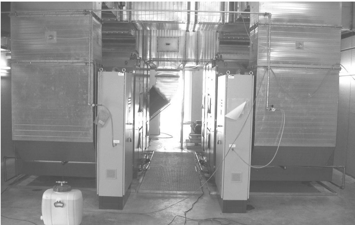
Bild 2.1: Gesamtanlage der elektrostatischen Luftfilter
