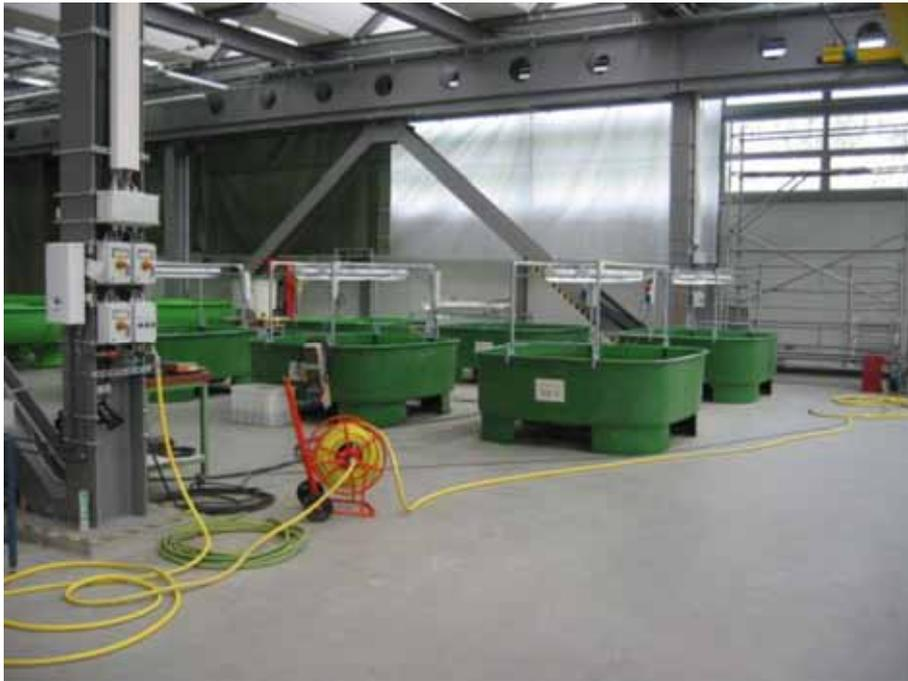
Abb. 82: Rundstrombecken mit Beleuchtung in der Hallenanlage der FSA
