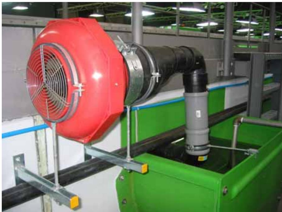
Abb. 81: Ventilator mit Ausströmöffnung über der Wasseroberfläche des Teiches
