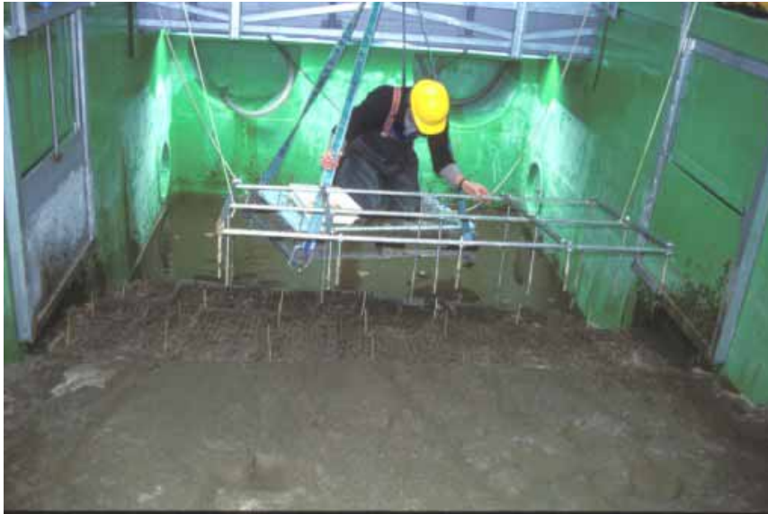
Abb. 17: Bepflanzung der Teiche (Quelle: Autoren)
