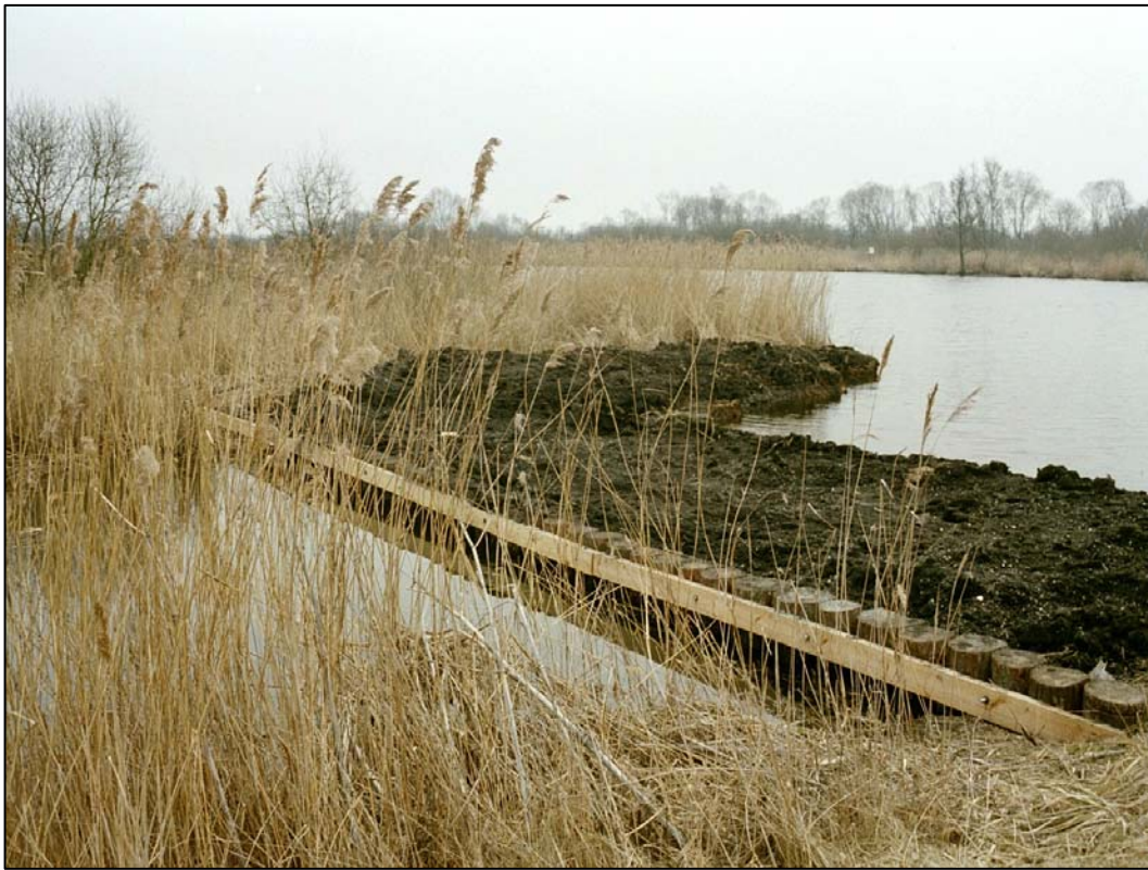
Abbildung 1: Verschluss von Entwässerungsgräben an der Peene
