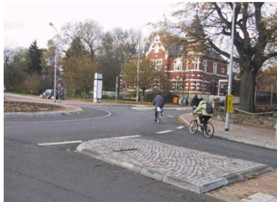
**Bild 6-17:** Zwischenlösung mit mobilen Elementen als Überquerungshilfen in großflächigen Knotenpunkten (Mauerstr.)
