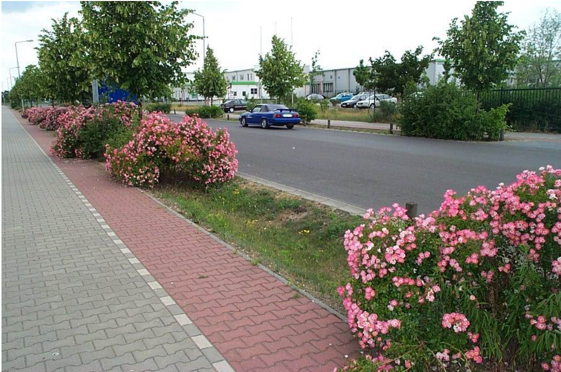
Abb. 1: Straßenbegleitendes Mulden-Rigolen-System
