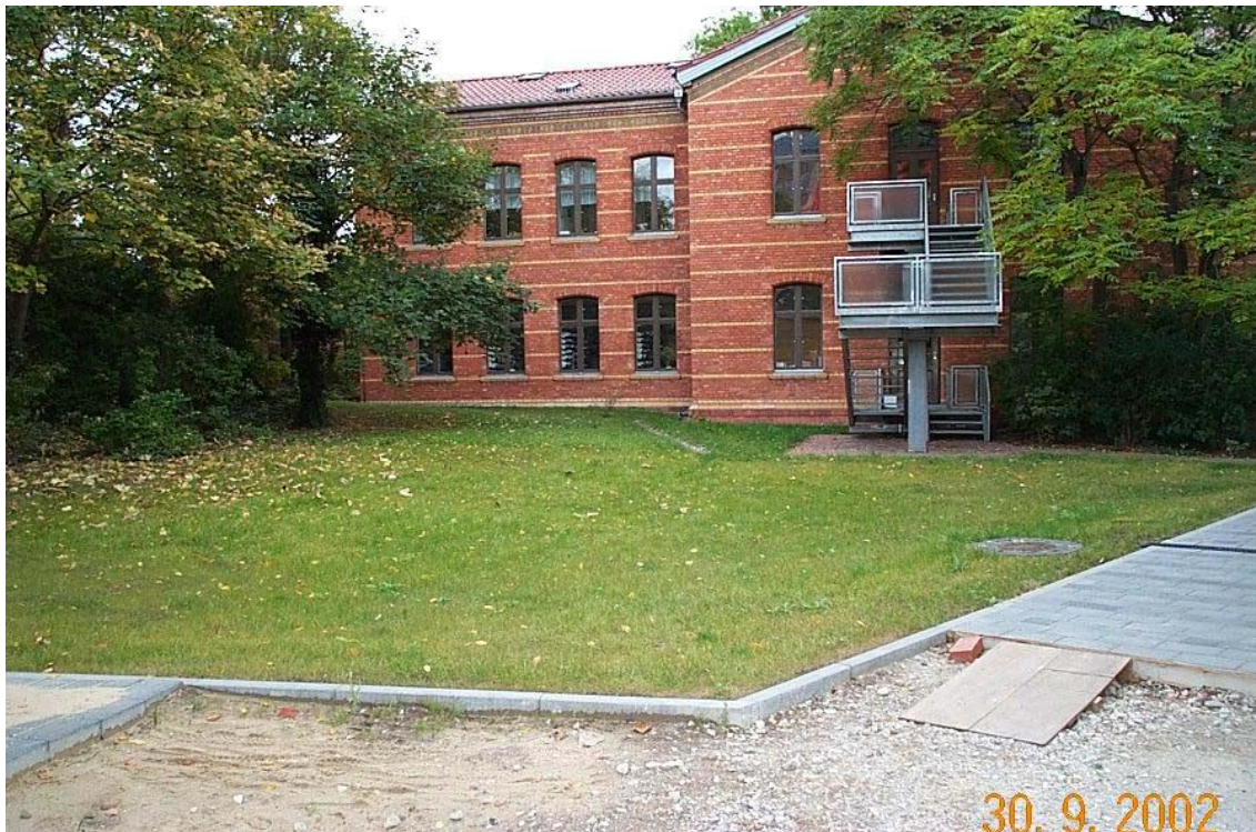
Abb. 14: Entwässerung von Hof- und Dachflächen über Mulden mit darunter liegenden Rigolen
