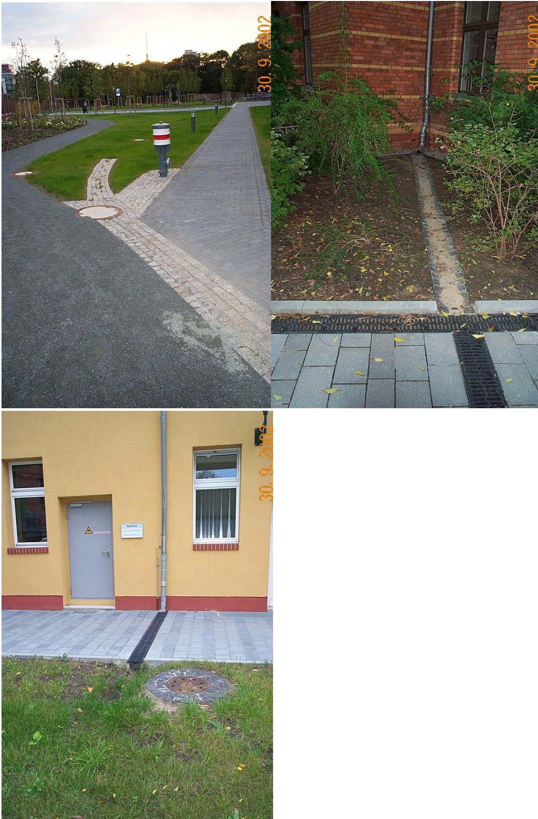
Abb. 16: Ausführungsbeispiele für Zuläufe zu den Mulden
