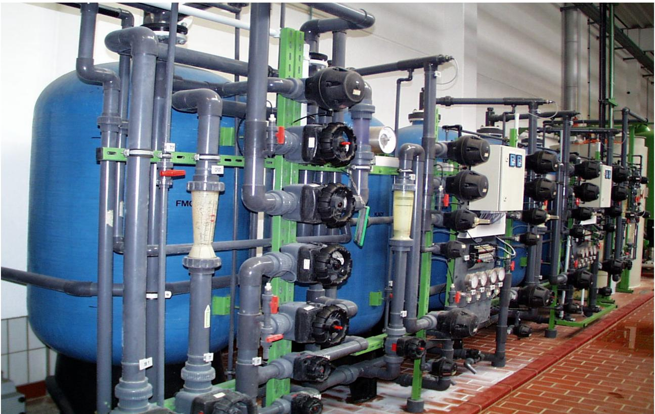
Bild 4 Regenerationsanlage Kreislaufwasser
