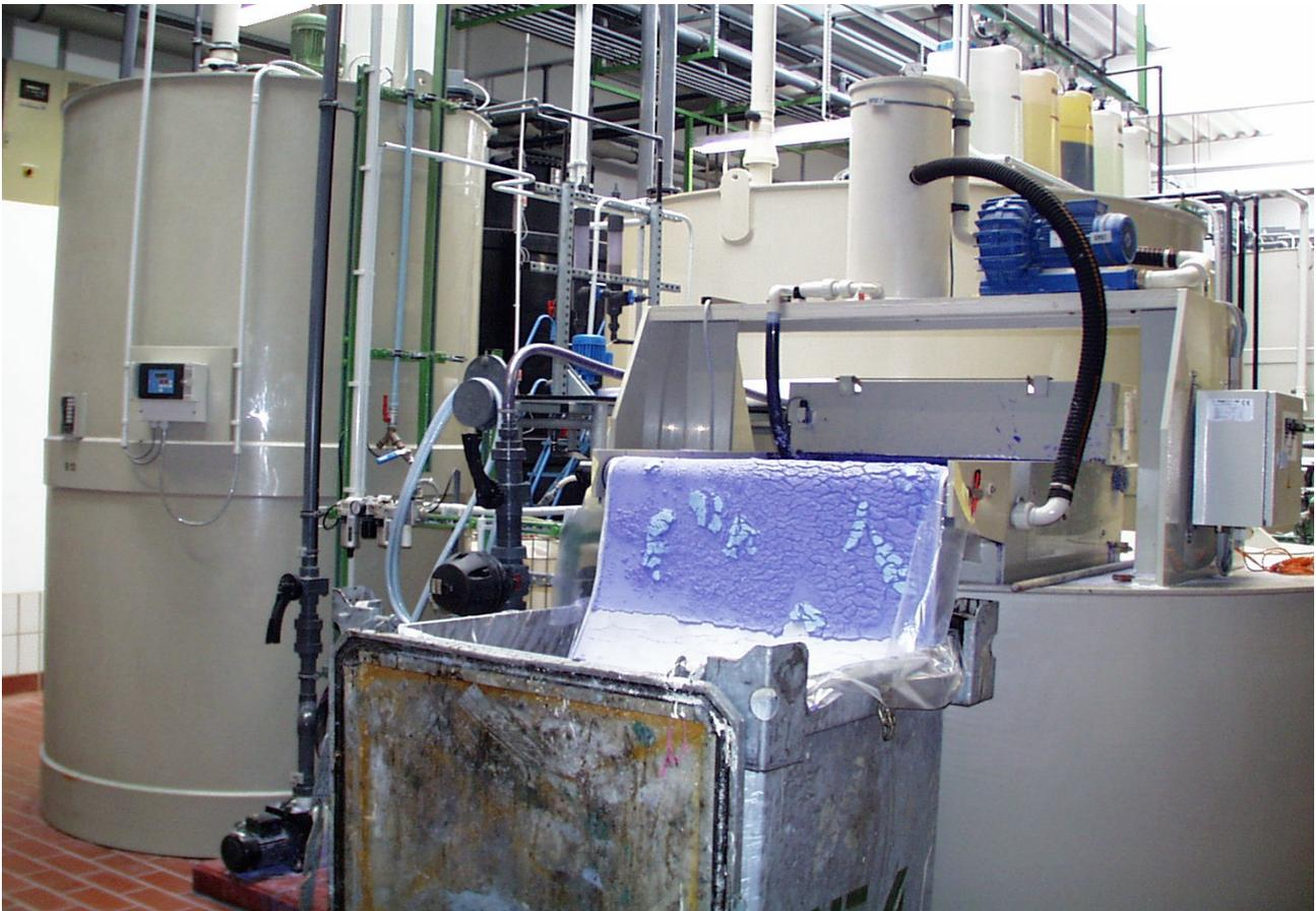
Bild 1 Reaktionsbehälter und Bandfilter der Resistbehandlungsanlage
