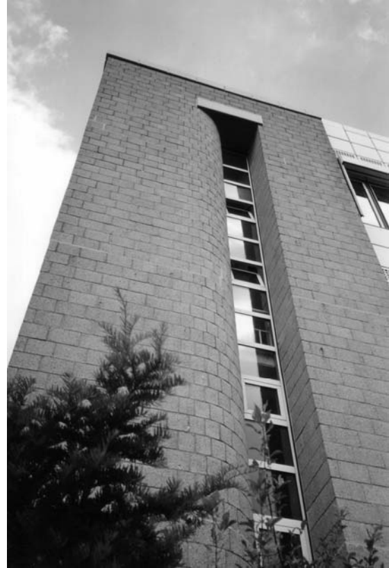
Abbildung 8: Dienstgebäude Langen – Außenansicht
