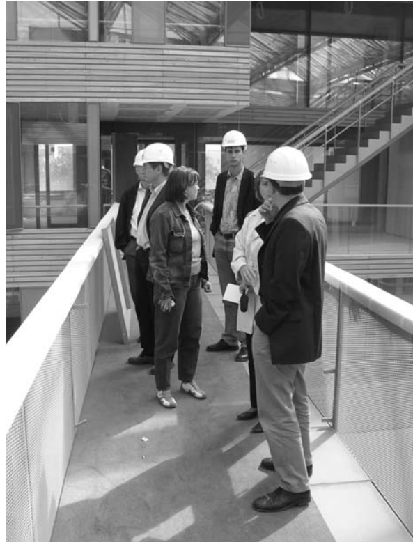
Abbildung 2: Mitglieder der UBA-Expertengruppe Ökologisches Bauen begehen die Baustelle des künftigen Dienstsitzes in Dessau
