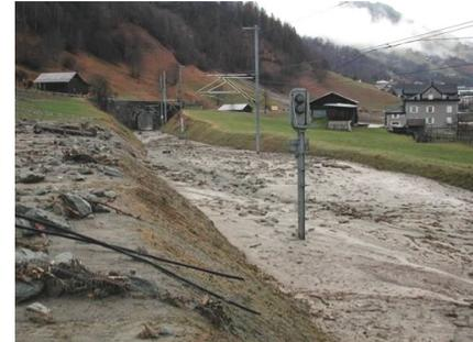
Photo : Voie ferrée RhB ensevelie sous une coulée de boue (22.11.2002, Campliun-Trun, canton des Grisons, CH); Eva Frick, tur gmbh, Davos
