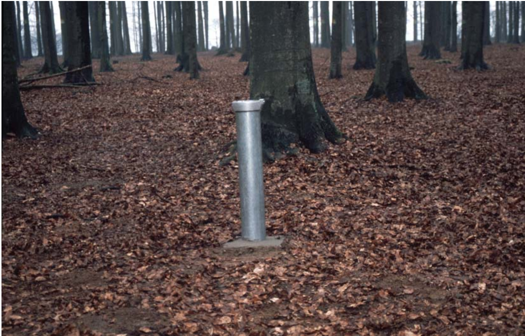
Abb. 18. Grundwassermessstelle im Untersuchungsgebiet Wankendorf (Foto: I. Stodian).
