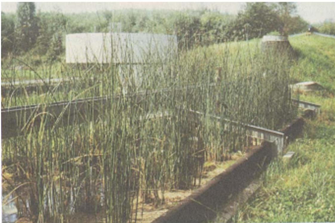
**Рис. 23: Растительная очистная установка [22]**
