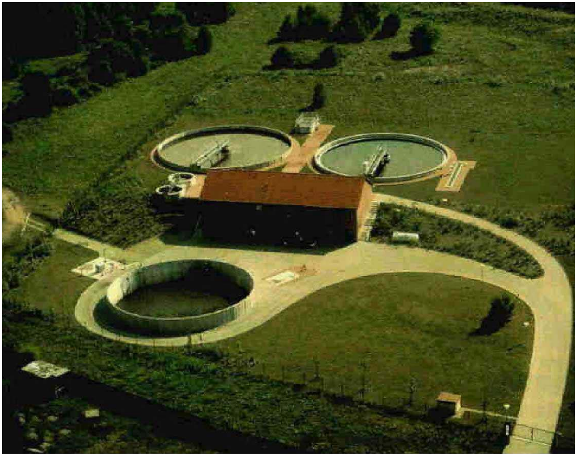
Abbildung 32: Kläranlage Königsbrück – 1. Ausbaustufe
