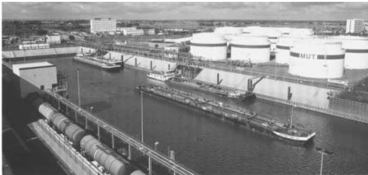
Abb. 59: Binnen-Tankschiffhafen mit Tanklager (Magdeburg / Elbe)
