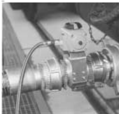
Abb. 62: Motorgesteuertes Schnellschluss-Ventil
