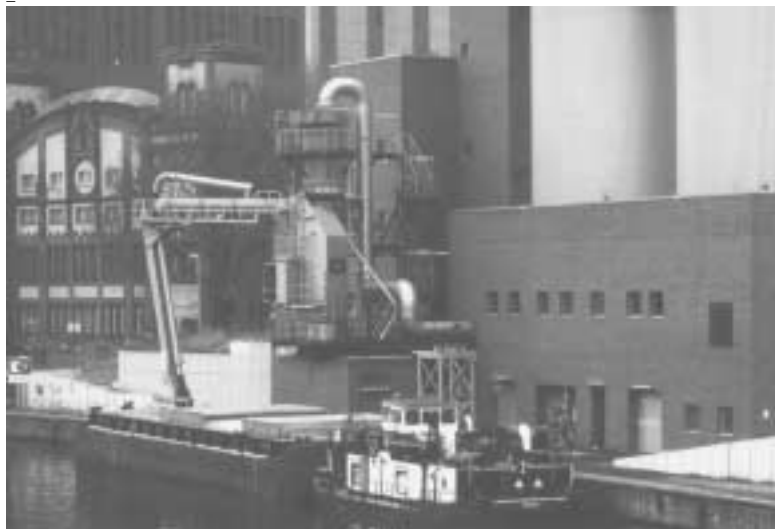
Abb. 55: Anlegestelle mit pneumatischer Kalk-Entladeanlage und Silo (Kraftwerk Berlin-Charlottenburg)
