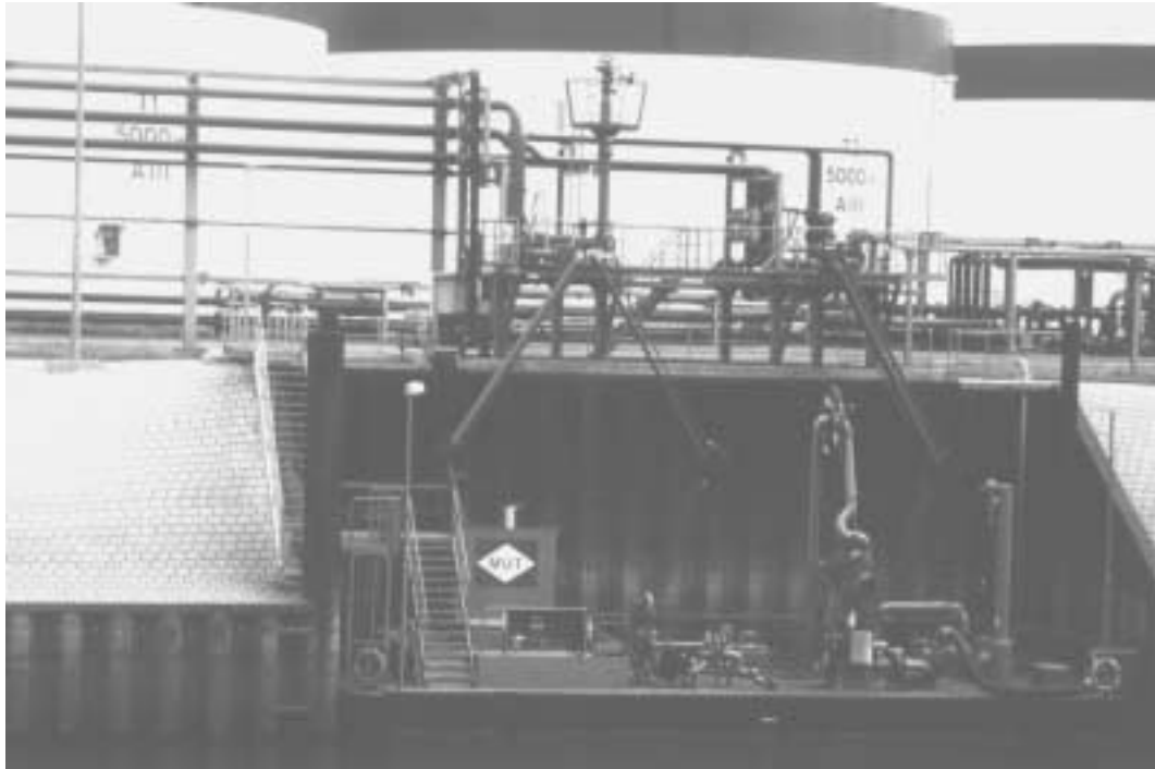
Abb. 60: Mineralöl-Entladestation und Lagertanks (Magdeburg / Elbe)
