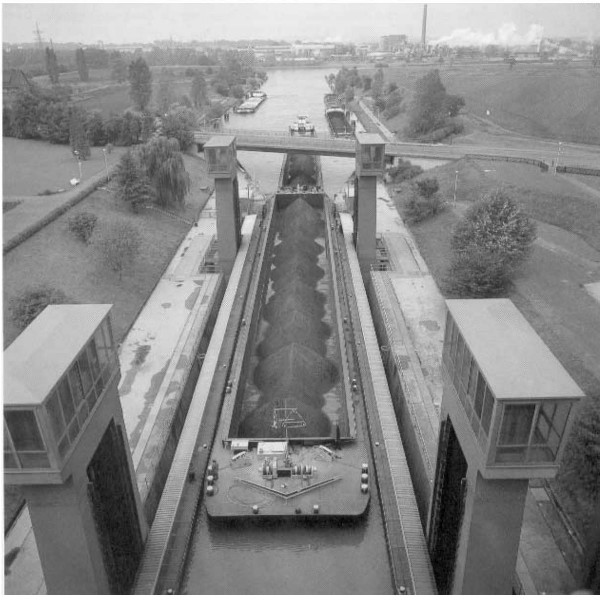
Abb. 20: Schleuse Henrichsburg mit einfahrendem Schubverband
