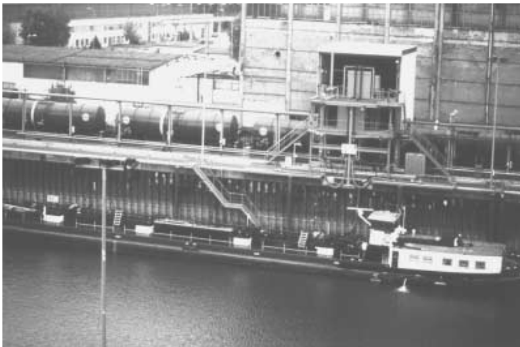
Abb. 61: Mineralöl- und Chemikalien-Umschlagsanlage (Direktumschlag Schiff / Kesselwagen – Magdeburg / Elbe)
