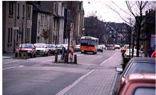
4.20: Baulich abgesetzter Mehrzweckstreifen
