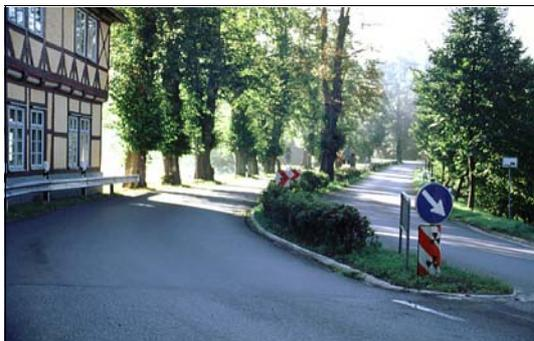
Bild 4.32: Mittelinseln in Kurvenlage bieten die beste Geschwindigkeitsreduzierung
