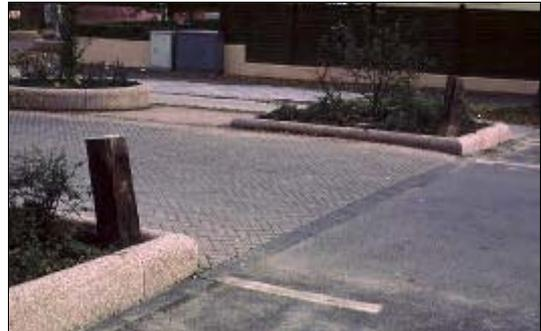
Bild 3.20: Aufpflasterung mit mittlerer Rampensteilheit
