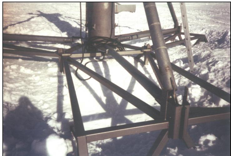
Abb. 7-8 und 7-9 Windgenerator und Einbau einer Fundamentsektion
