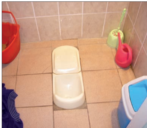
Vas WC în interiorul camerelor toaletei (tip turcesc)
