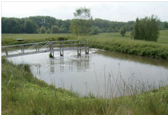
Bazin de aerare Schlamerdorf, Germania
