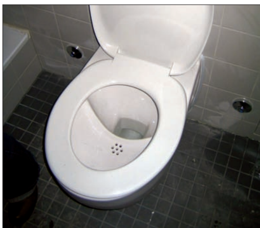
Toalete cu jet redus de apă după separarea urinei
