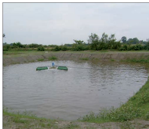
Bazin de aerare 3, aerator de suprafață
