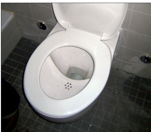
Тоалетна с разделяне и отмиване на урината
