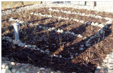
Локална изкуствена влажна зона за пречистване на отпадъчната вода от домакинство, Полша
