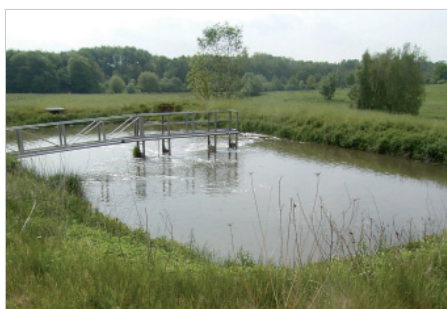
Аерационен басейн Шламердорф, Германия
