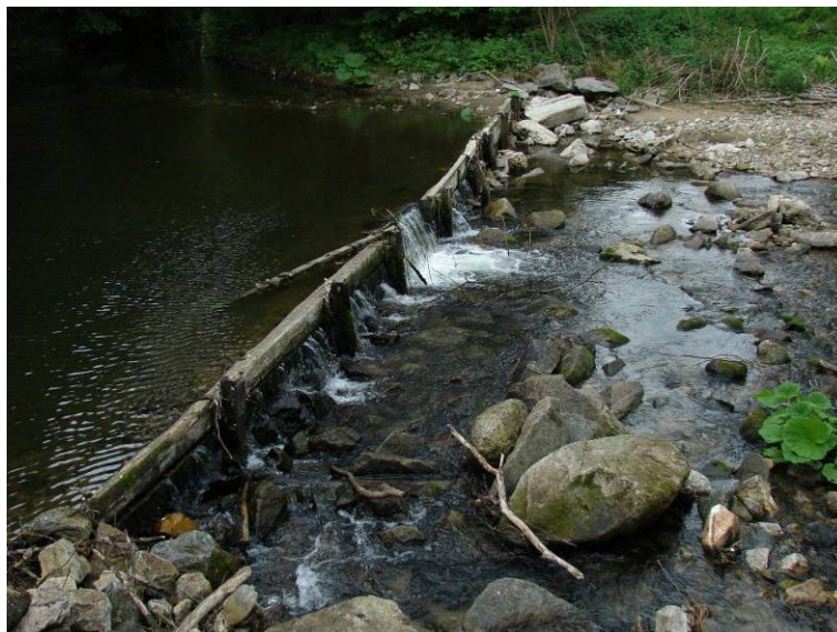
Fotografia 1: Bariéra na rieke – odberný objekt MVE
