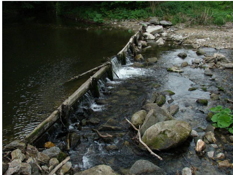
Foto 1: Barriere im Fluss bei der Ableitung des Wasserdammes Miková
