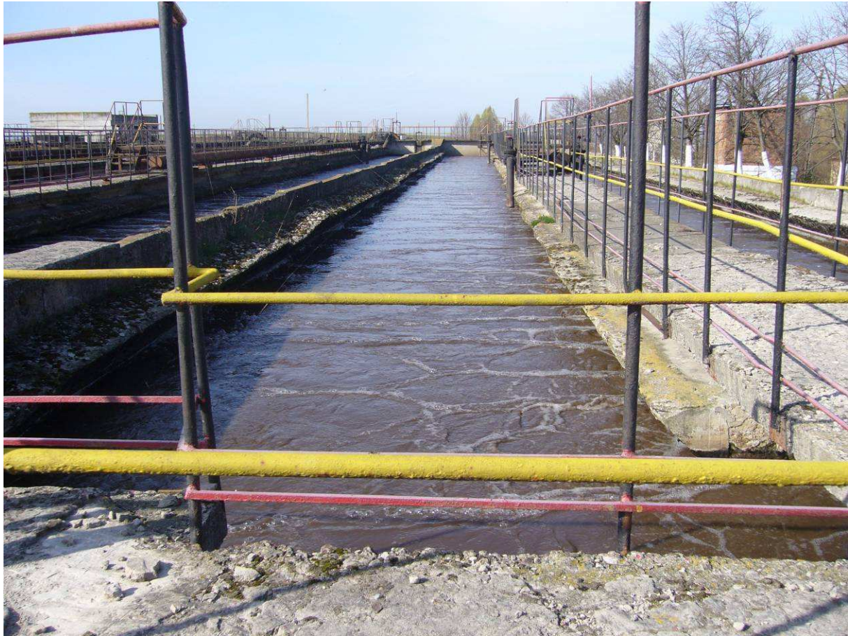
Малюнок 13: Аеротенки на очисних спорудах м. Нововолинськ
