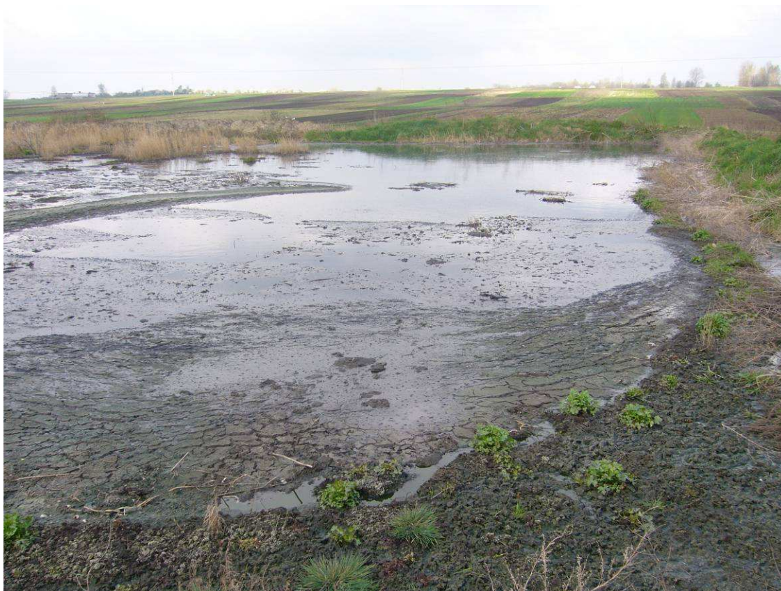
Малюнок 10: Переповнені мулові майданчики на очисних спорудах м. Червоноград
