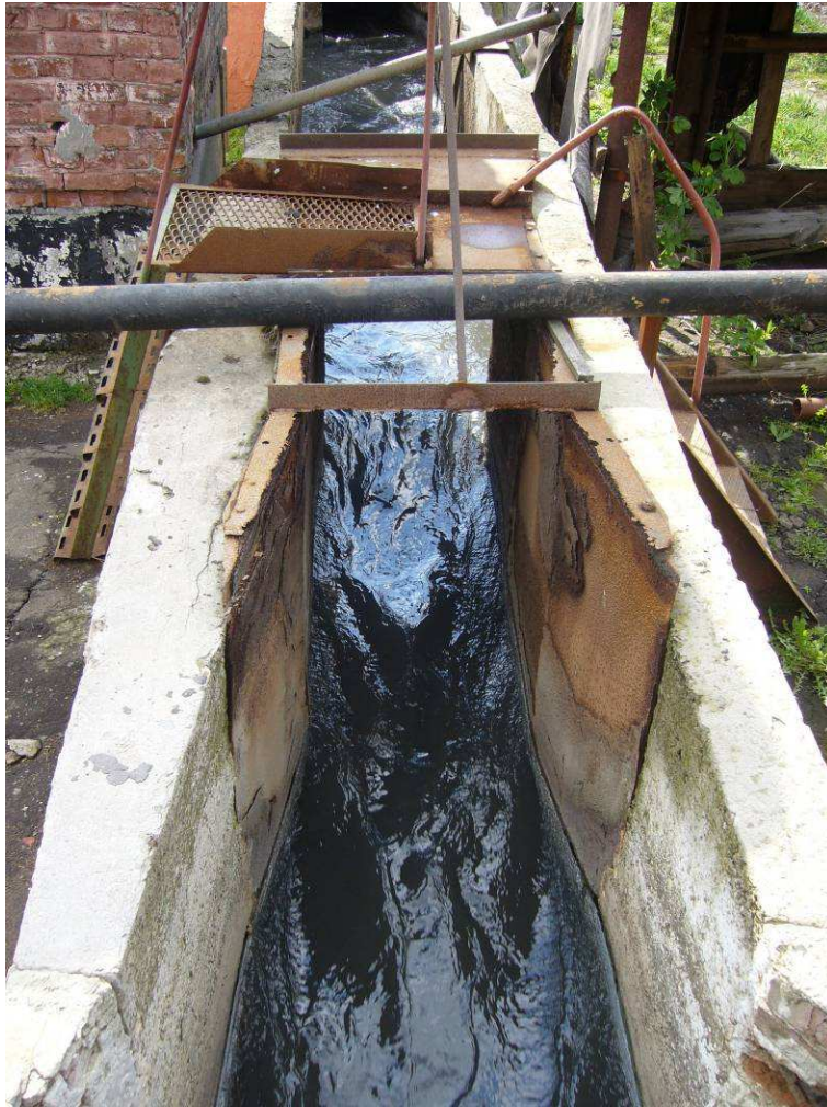
Малюнок 15: Вимірювальний канал Вентурі на вході ОС м.Червоноград
