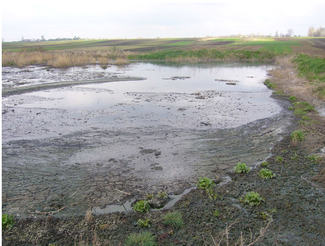
Rysunek 10 Przepełnione poletka osadowe na terenie oczyszczalni ścieków w Czerwonogradzie.
