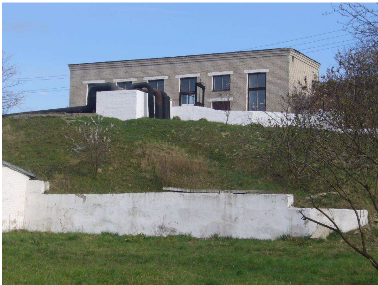
Rysunek 19 Komora zasilająca oczyszczalni w Czerwonogradzie.
