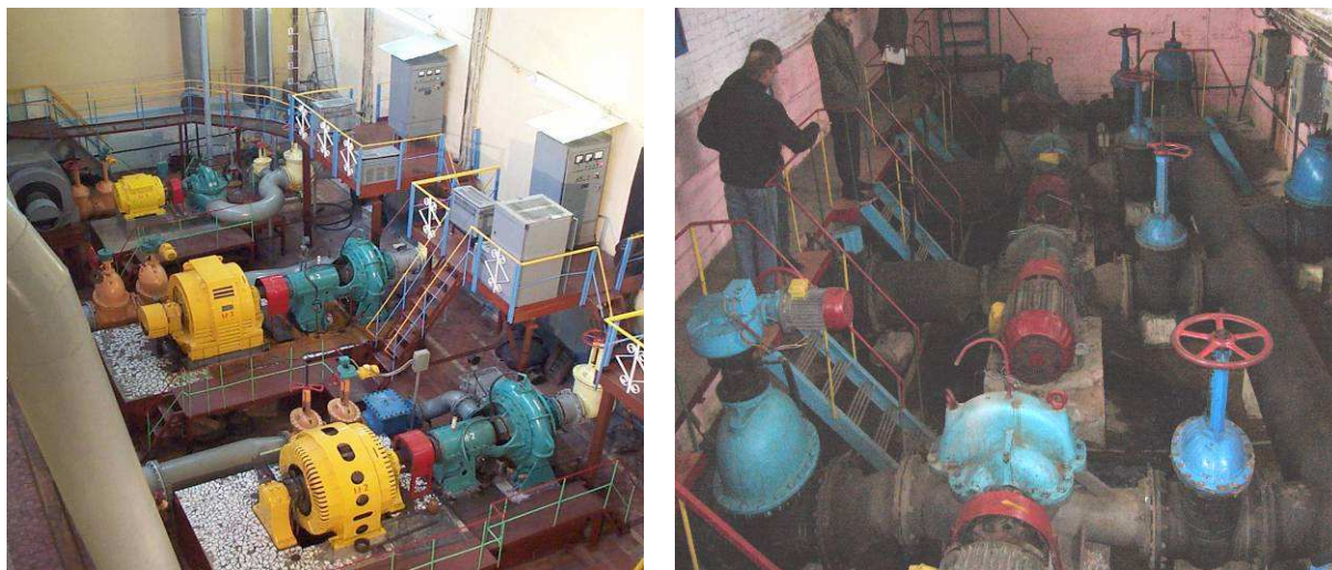
Rysunek 8 Nowoczesne (miasto Czernigów, po lewej) i przestarzałe pompownie (miasto Czerwonograd, po prawej)
