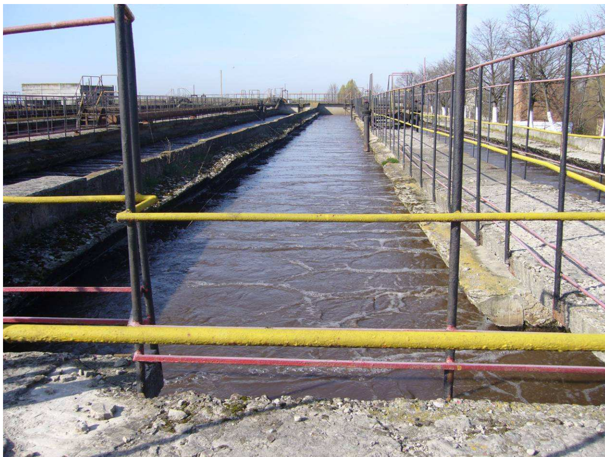
Rysunek 13 Komory napowietrzania w oczyszczalni ścieków w Nowowołyńsku
