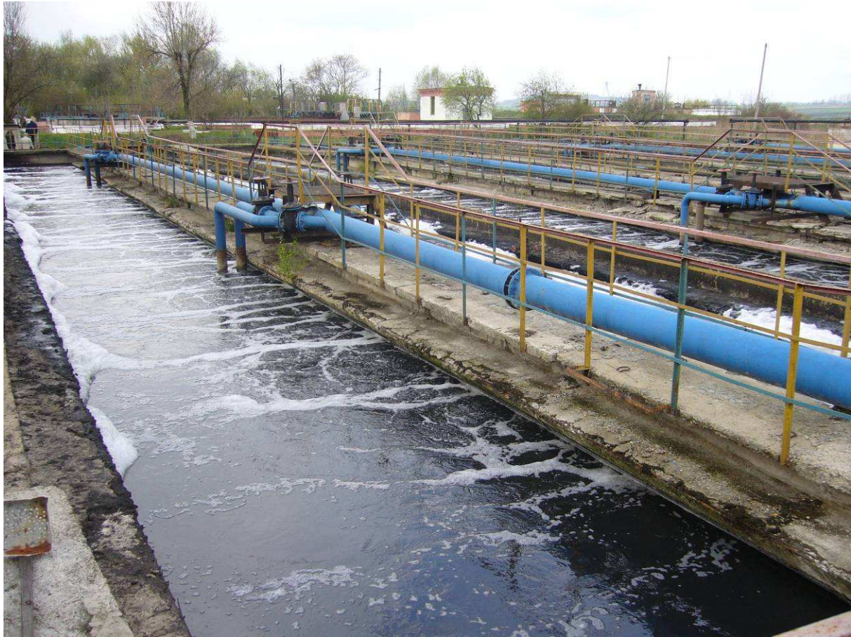
Rysunek 16 Komora napowietrzania w OŚ w Czerwonogradzie
