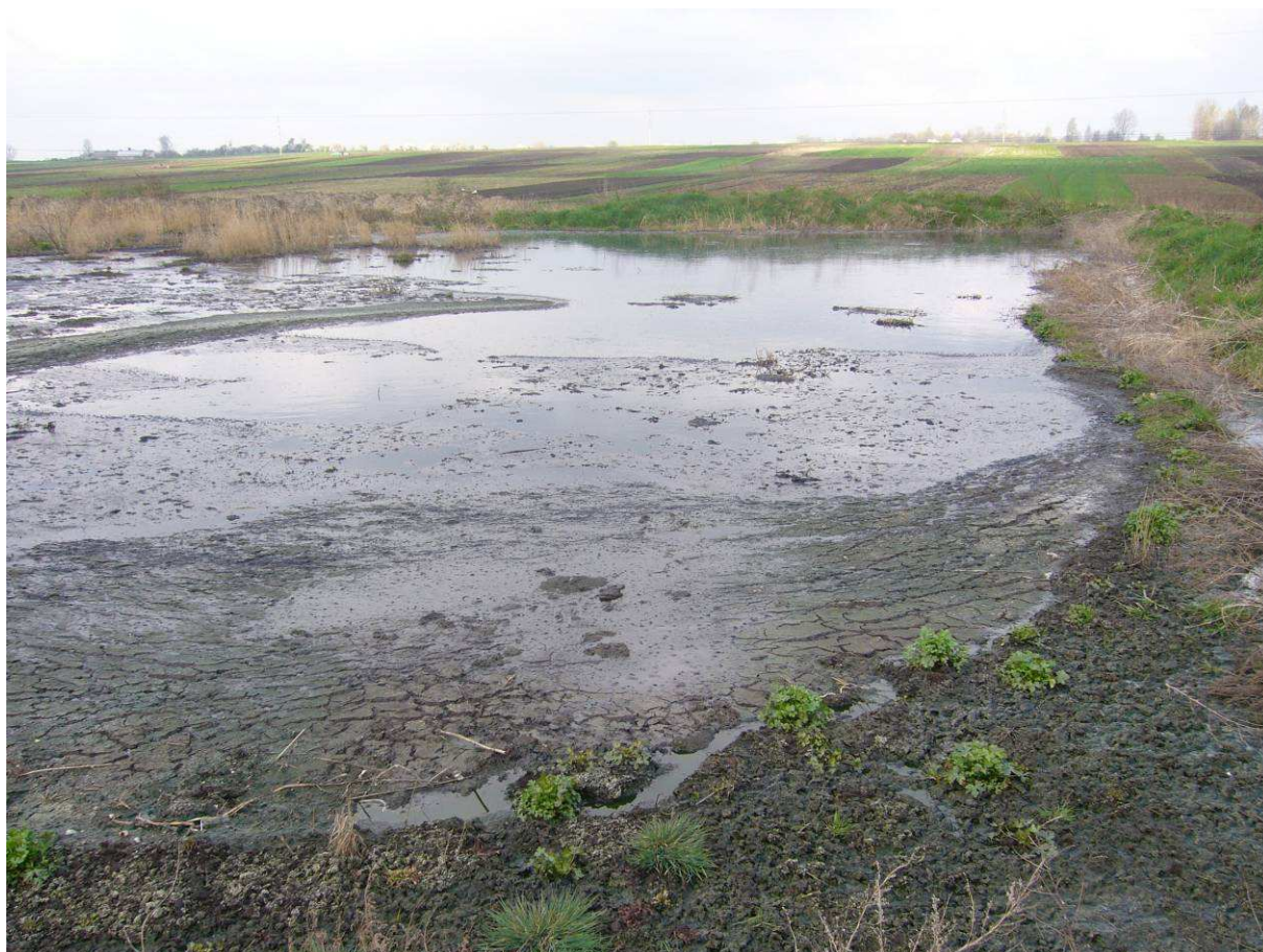
Rysunek 17 Poletka osadowe w OŚ w Czerwonogradzie
