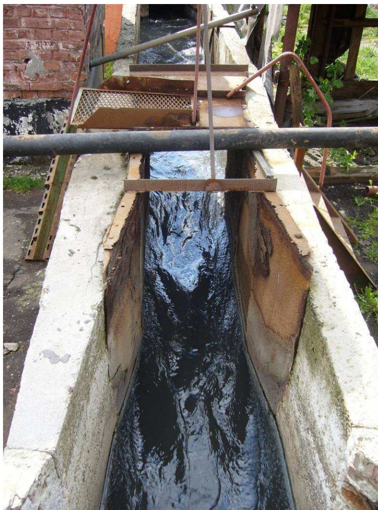
Rysunek 15 Kanał mierniczy Venturi na wlocie OŚ Czerwonograd
