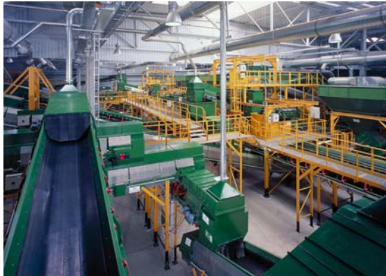
Mechanische Aufbereitung einer MBA-Anlage Quelle: Linde-KCA-Dresden GmbH
