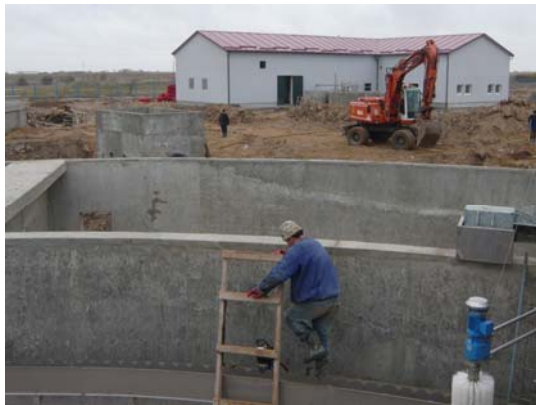
Die TeilnehmerInnen besichtigten während einer Exkursion den Neubau einer Kläranlage in Gusev. Foto: K. Döscher
