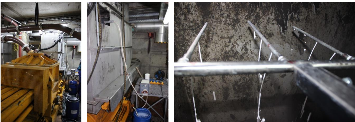
Abbildung 44: Eindüsung des Nanomaterials im ZVK Steinhäule
