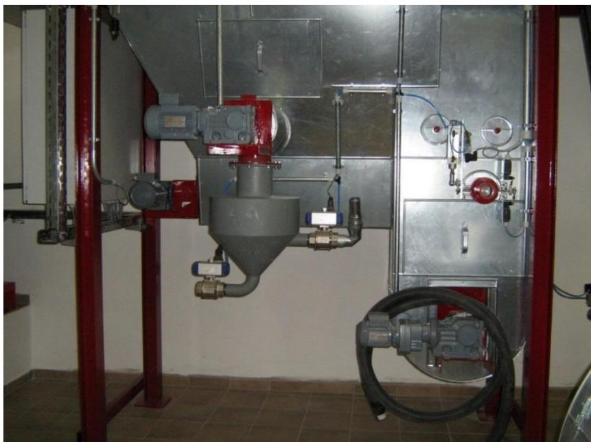
Photo: IFZW GmbH (Zwickau): rechtes Bauteil: Kugelrotor, linkes Bauteil: Ascheaustrag aus dem Gewebefilter
