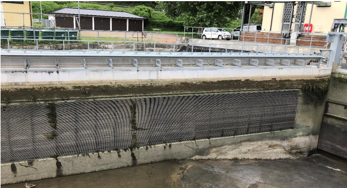
Abbildung 11: Teil des Fischschutzsystems an der Wasserkraftanlage Rappenberghalde am Neckar bei Tübingen. Blick auf den horizontalen Leitreehen mit 15 mm lichtem Stababstand und Betonsockel. Am rechten Bildrand ist das Schütz zum Leerschuss teilweise zu sehen
