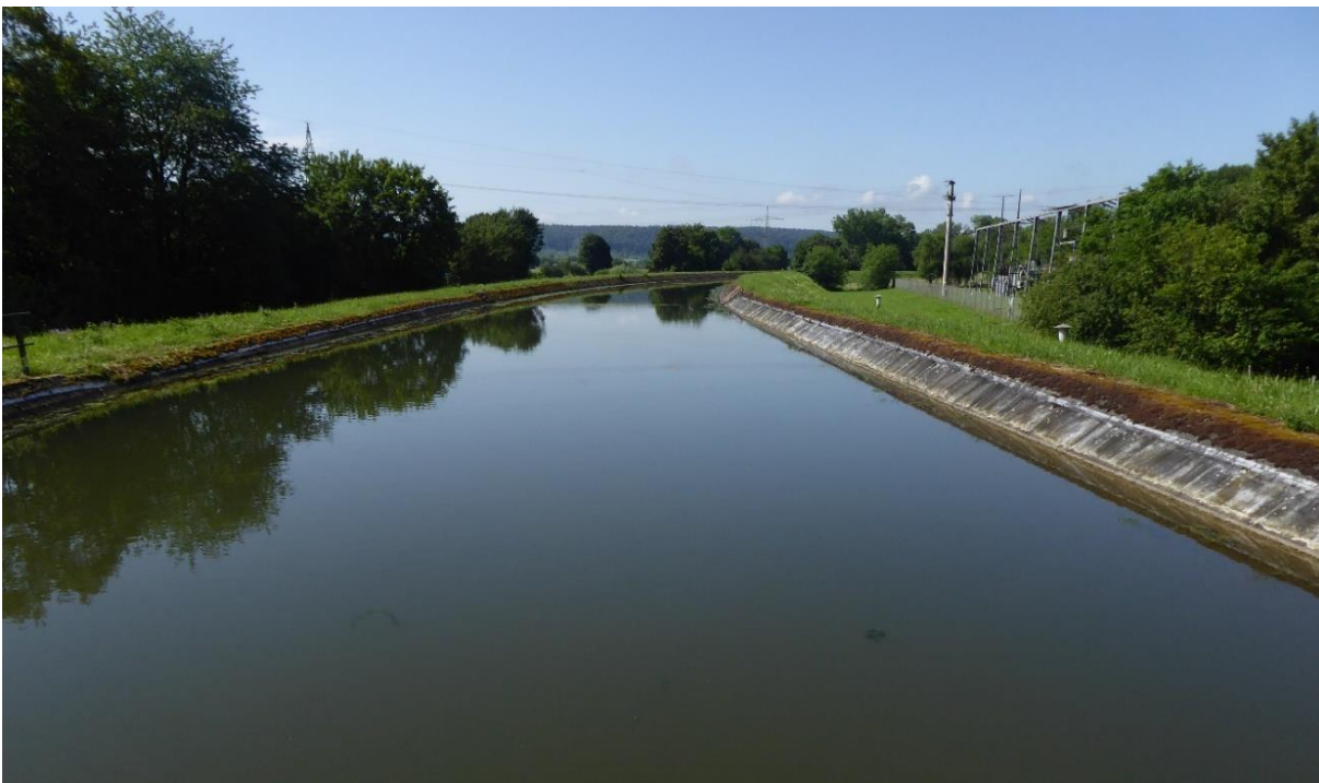
Abbildung 9: Kanal mit Trapezprofil oberhalb der Wasserkraftanlage Rappenberghalde
