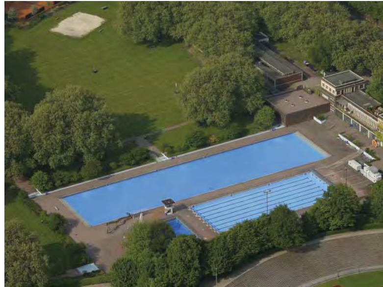
Freibad Gladbeck: Betriebsführung durch den örtlichen Schwimmverein
