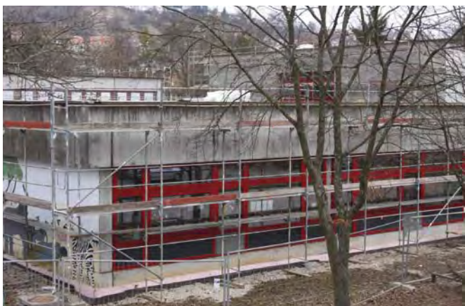
Energetische Gebäudesanierung der Grundschule in Aischbach, Tübingen
