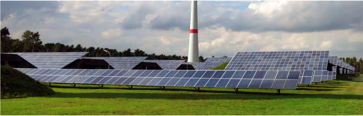
Foto: Photovoltaikanlagen im Bioenergiepark Saerbeck (Claudia Feldmann Fotografie)
