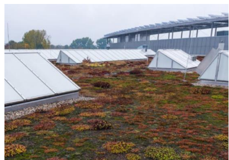
Extensive Dachbegrünung (© KWB/Andreas [FranzXaver] Süß)
