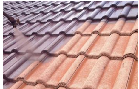
Beschichtung von Dachziegeln bei Sanierung (© KWB)
