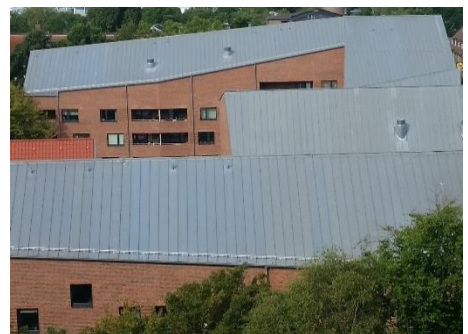
Großflächiges Metalldach aus Zinkblech (© OST)
