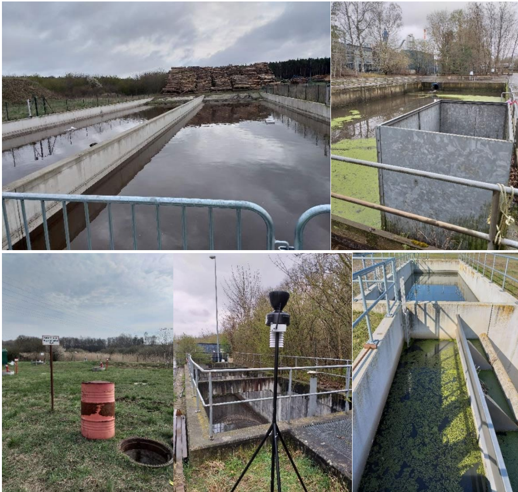
Abbildung 5: Eindrücke von den beprobten Becken
