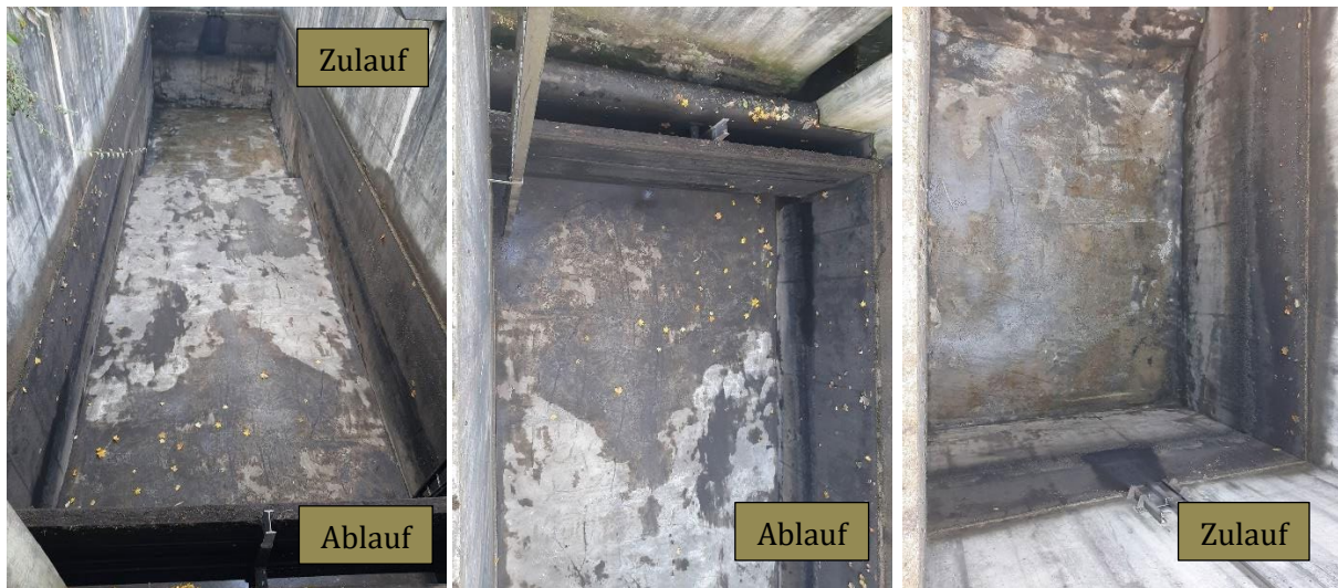
Abbildung 17: Blick in Regenklärbecken D nach Schlammräumung
