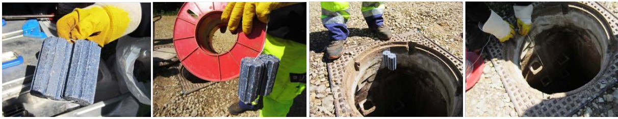
Abbildung 4: Ausbringung von Fraßködern am Draht bei Rattenbekämpfungsmaßnahmen in der Kanalisation
