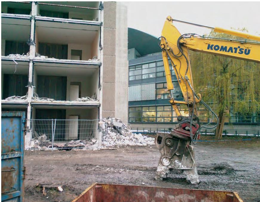
Abbildung 20: Hydraulikbagger mit hydraulisch drehbarer Abbruchzange (Betonbacken)
