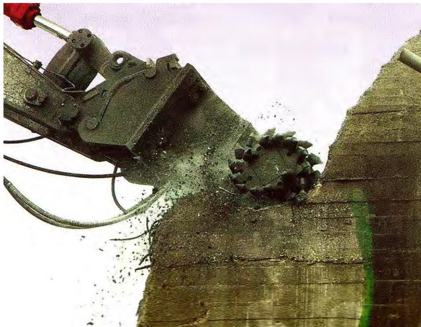
Abbildung 21: Betonfräse beim Bunkerabbruch [72]
