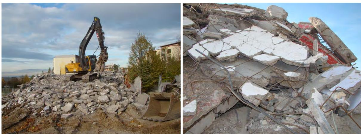
Abbildung 31: Bagger bei der Vorsortierung und Vorzerkleinerung Vorort (links) und Badzellenwand (rechts)
