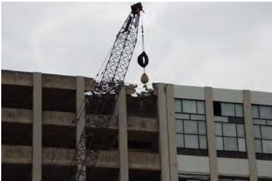
Abbildung 22: Einschlagen mit einem Seilbagger mit angehängtem Stahlkörper [59]
