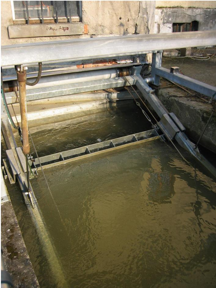
Abb. B. 7: Feinrechen mit Spülrinne und Harke der Rechenreinigungsmaschine
