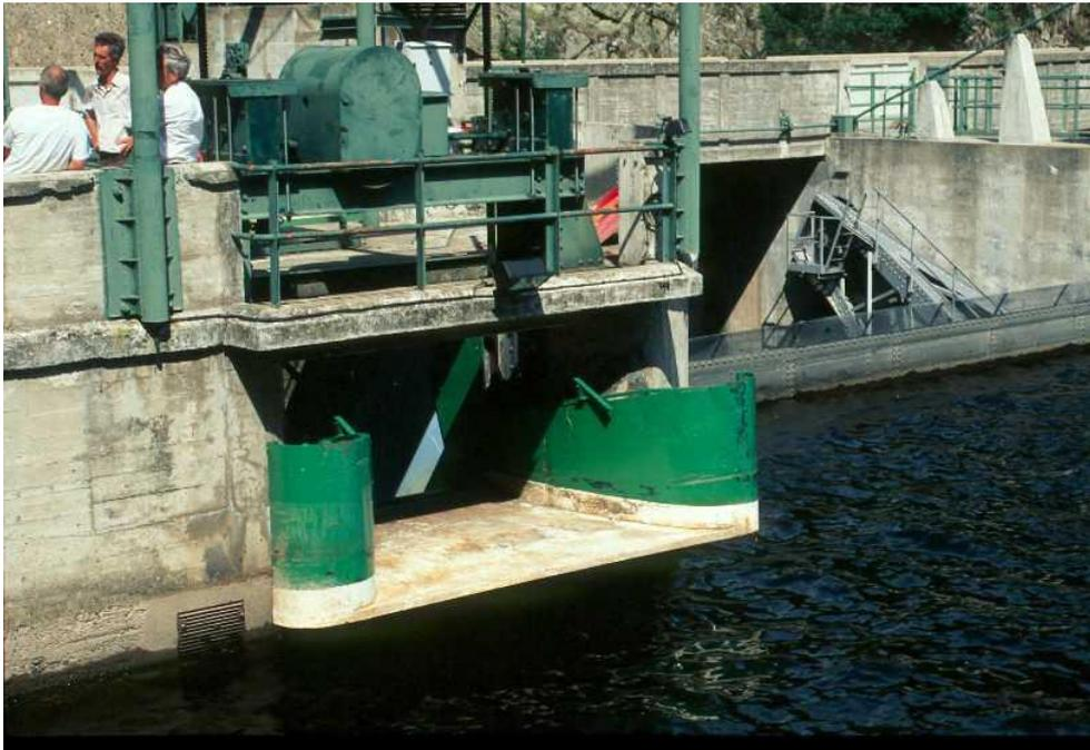
Abb. B. 20: Bypass-Düse für atlantische Lachsmolts mit Beleuchtung zur Verbesserung der Attraktionswirkung: Der Einlauf des Bypasses am Staudamm Poutès im Allier ist so geformt, dass möglichst geringe Turbulenzen entstehen und die Strömung stetig beschleunigt wird. Der Bypass ist höhenverstellbar und kann so an wechselnde Oberwasserstände angepasst sowie außerhalb der Betriebszeiten über die Wasseroberfläche emporgehoben werden.
