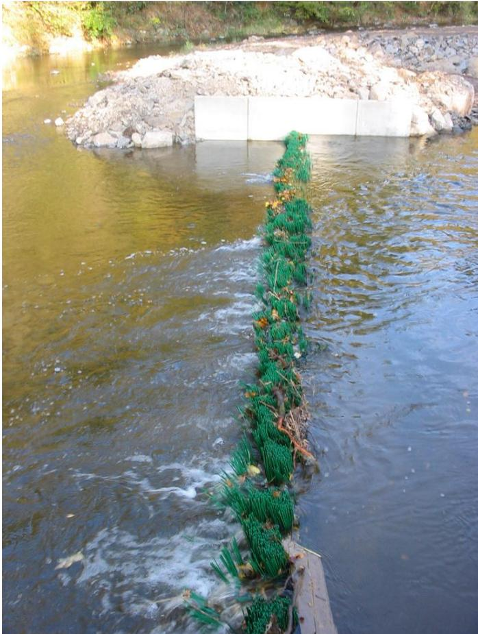
Abb. A.7: Aufwändersperre mit Borsten an der Mündung eines Unterwasserkanals (Our)
