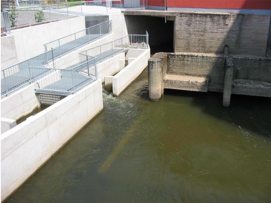
Abb. A.9: Unterwasseransicht der Wasserkraftanlage Klinkelsche Mühle in Gießen (Hessen) mit korrekter Anordnung des Einstiegs in die Fischaufstiegsanlage
