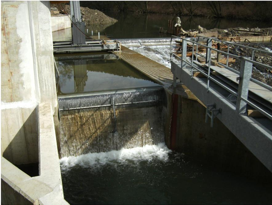
Abb. B. 11: Blick auf das eigentliche, überströmte Kraftwerk. Der Rechenreiniger befördert das Rechengut in den Kanal über der Turbine und es wird durch Öffnen der Klappe abgespült. Dieser Kanal fungiert gleichzeitig als oberflächennaher Bypass.
