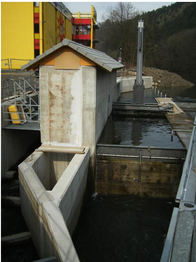
Abb. B. 12: Links die FAA, die landseitig um das Kraftwerk führt. In der Mitte liegt der Zugangschacht, rechts das überströmte Krafthaus.
