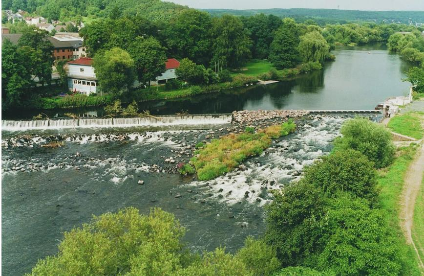
Abb. A.23 Fischaufstiegsanlage (Buisdorf /Sieg, NRW) Raugerinne mit einer Mischung aus Querriegeln und Störsteinen und seitlicher Verschneidung, die jedoch nicht gut passierbar war. Daher wurde in diesem Bereich ein Vertical-Slot-Pass zusätzlich eingebaut (Quelle: Städler).
