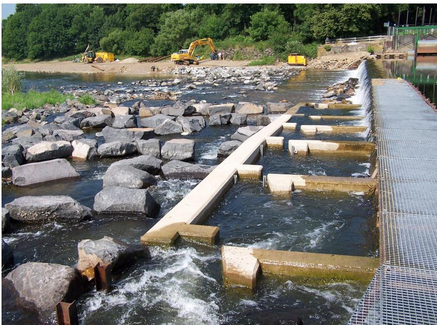
Abb. A.24 Fischaufstiegsanlage (Buisdorf/Sieg, NRW), nachträglich installierter Vertical Slot Pass in der seitlichen Verschneidung (Quelle: Nemitz).
