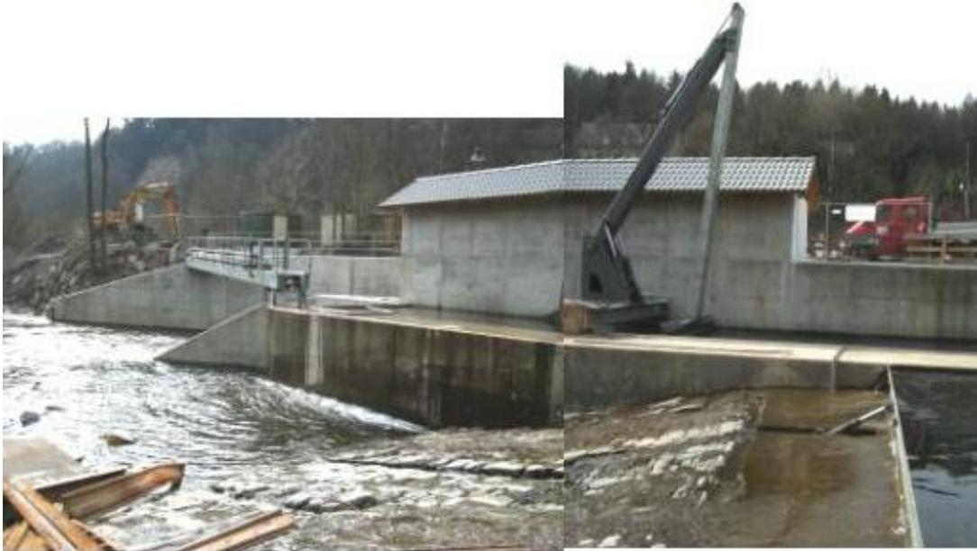
Abb. B. 9: Gesamtansicht der WKA Sigambria, Blick vom Wehr. Der Zulauf zur Turbine und der Rechen befinden sich zwischen Trennwand und Zugangsgebäude. Der Unterwasserauslauf liegt links.
