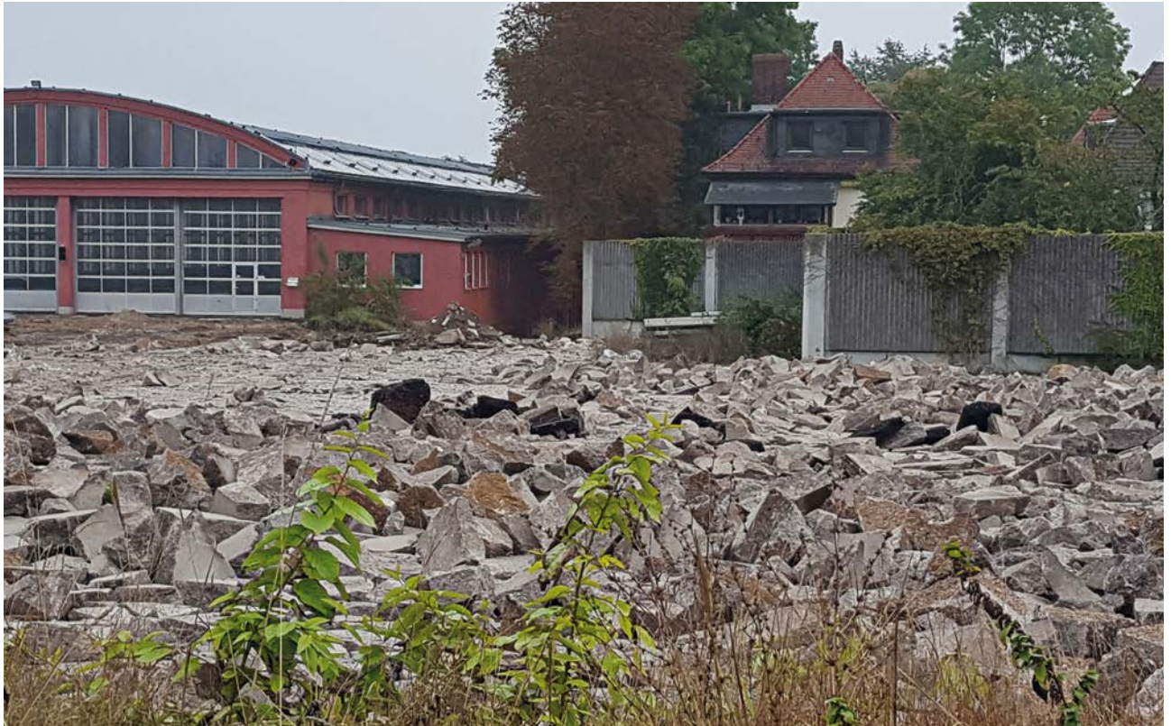
Abbruch einer Verkehrsfläche aus Beton
