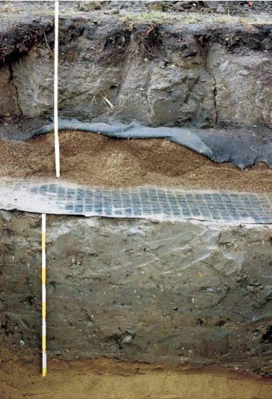
Bild 51: Aufbau des Abdecksystems für eine Altdeponie
