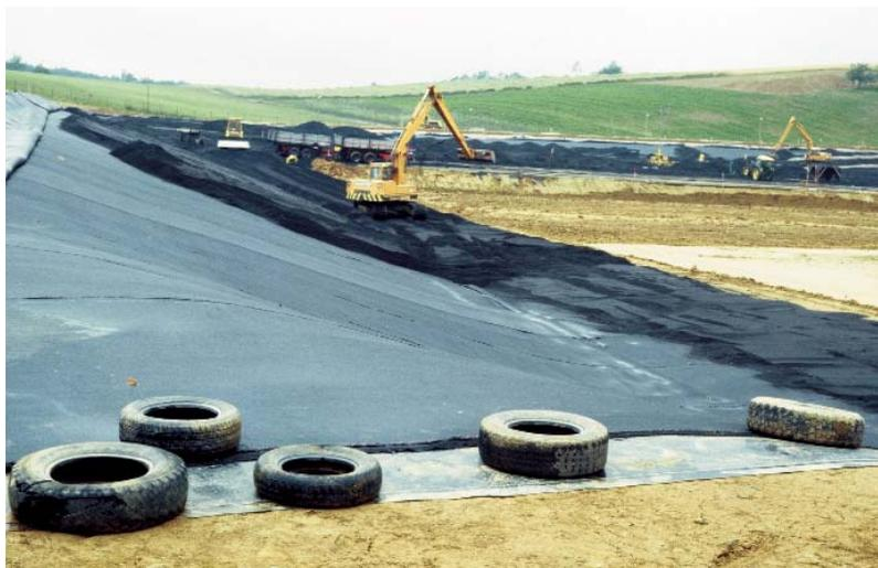
Bild 52: Bau der Basisdichtung einer Abfalldeponie
