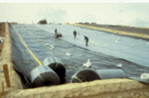
Um das Durchsickern von gefährlichen Stoffen in das Grundwasser zu vermeiden, werden unter neuen Deponien undurchlässige Kunststoffbänder ausgelegt.
