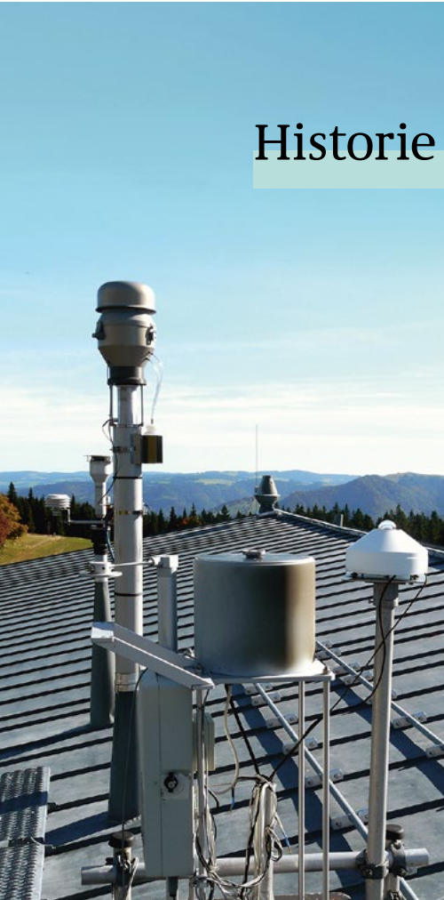
Ansaugstutzen und Messeinrichtungen auf dem Dach der Messstation Schauinsland im Schwarzwald
